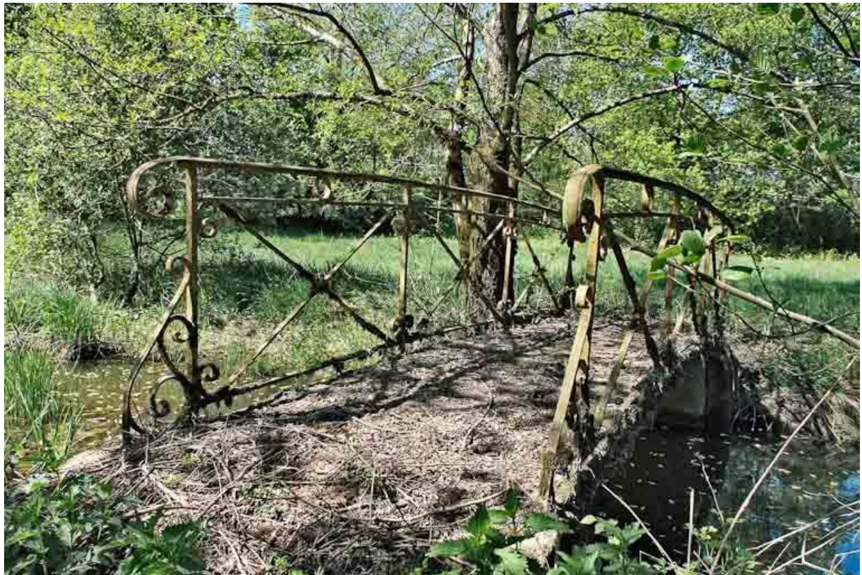
Passerelle métallique sur le Bief Michaud.
