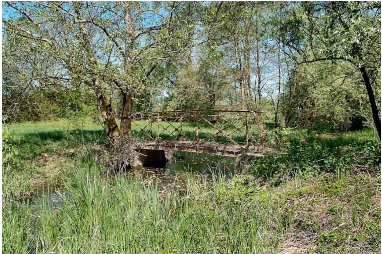
Passerelle métallique sur le Bief Michaud.
