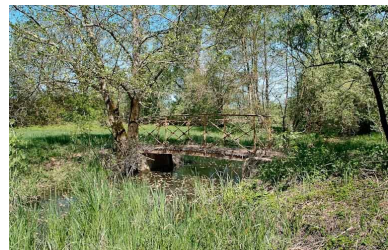
Passerelle métallique sur le Bief Michaud.
