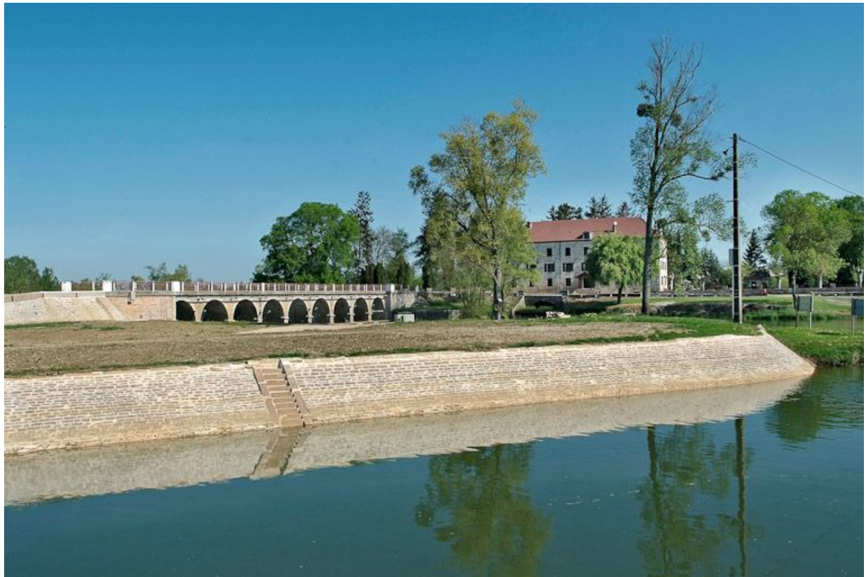
Barrage et pont de La Truchère à gauche, moulin à droite, au fond. Au premier plan : perré de l'écluse de La Truchère.
