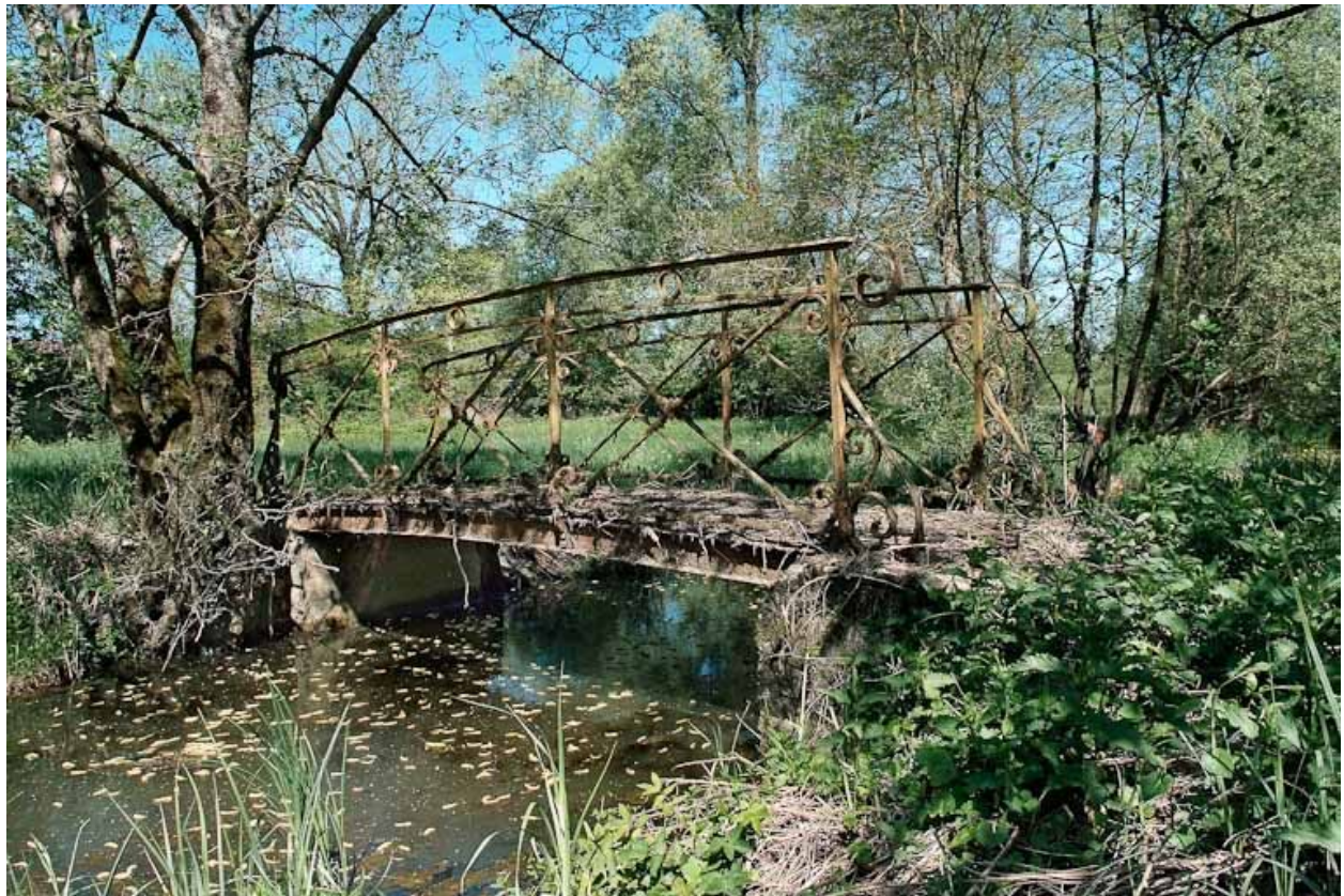
Passerelle métallique sur le Bief Michaud.
