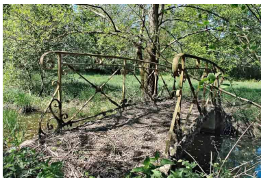
Passerelle métallique sur le Bief Michaud.
