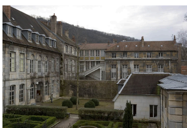
Vue d'ensemble de la façade sur cour, de trois quarts gauche. Phot. Yves Sancey IVR43_20072500192NUCA
