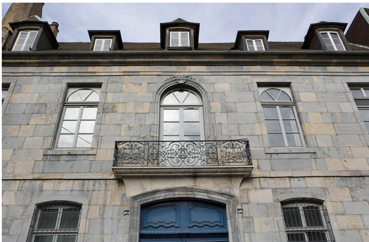
Détail de la façade sur rue de face.
