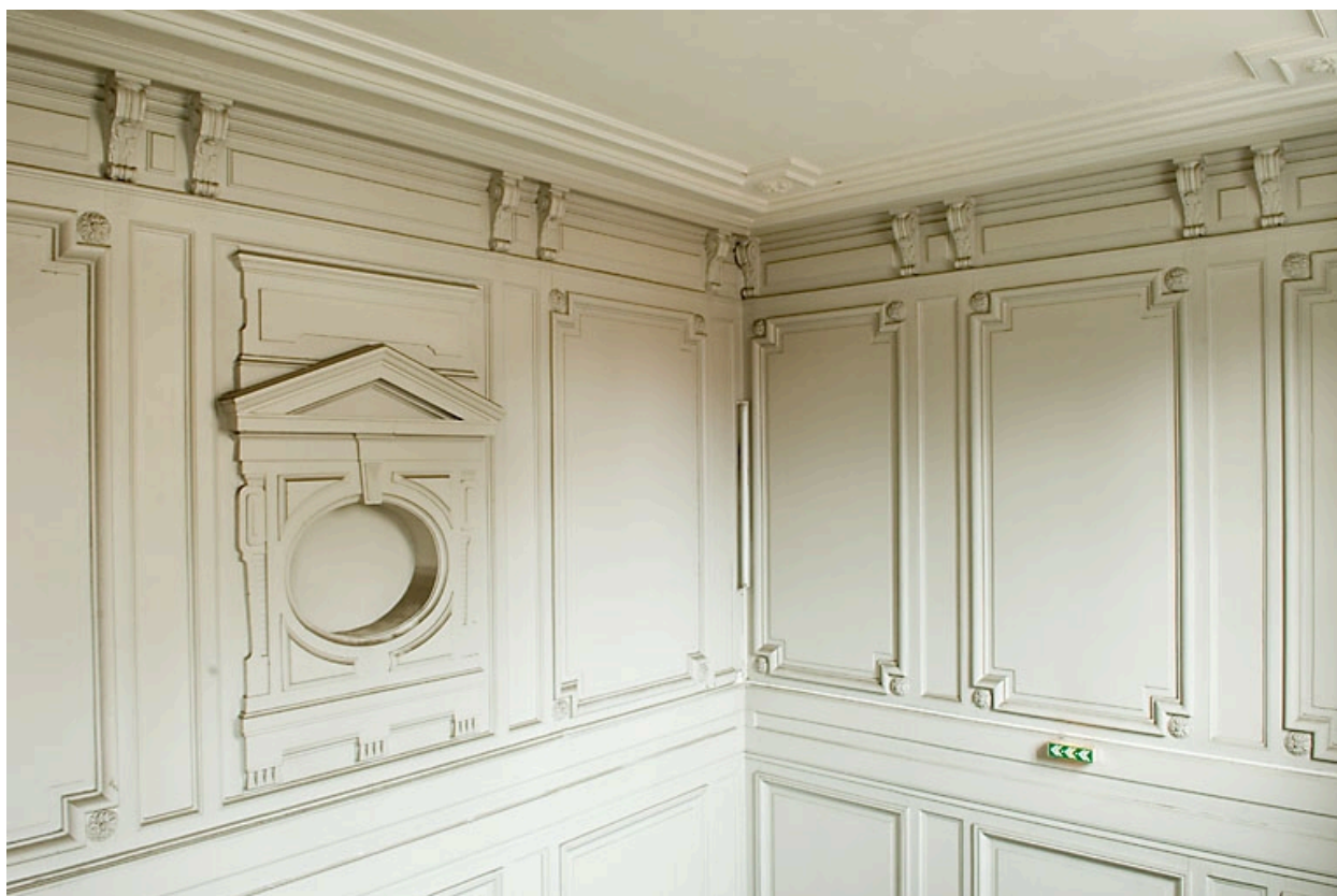
Détail du décor de la cage d'escalier.
