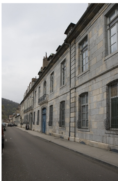
Vue d'ensemble de la façade sur rue, de trois quarts droit. Phot. Yves Sancey IVR43_20072500194NUCA
