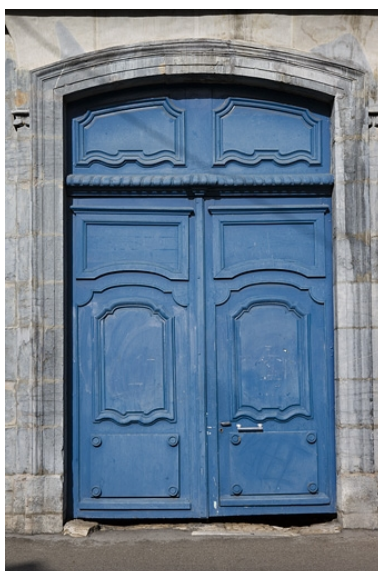
Détail du portail d'entrée. Phot. Yves Sancey IVR43_20072500183NUCA
