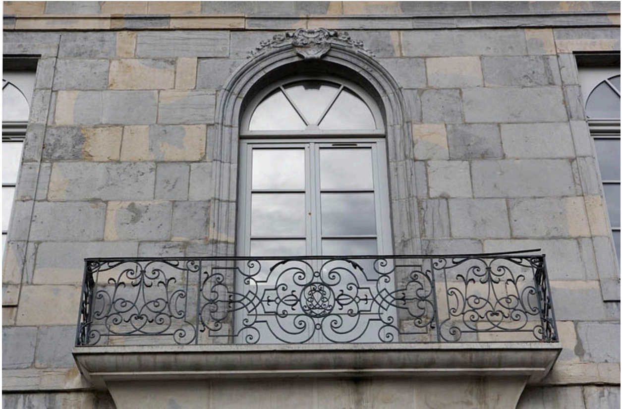
Détail du balcon en fer forgé sur rue.
