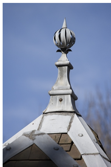
Bâtiment des anciennes écurie et remise : détail d'un épi de faitage. Phot. Yves Sancey IVR43_20072500188NUCA
