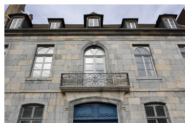
Détail de la façade sur rue de face. Phot. Yves Sancey IVR43_20072500181NUCA
