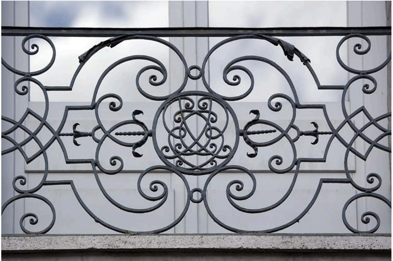
Façade sur rue : détail de la partie centrale de la ferronnerie du balcon.
