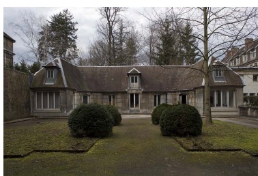
Bâtiment des anciennes écurie et remise : vue d'ensemble. Phot. Yves Sancey IVR43_20072500189NUCA
