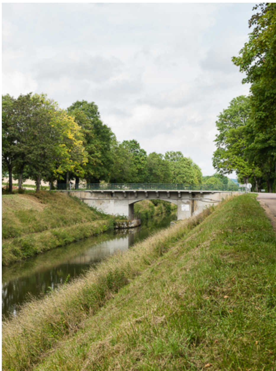
Vue d'ensemble du pont.
