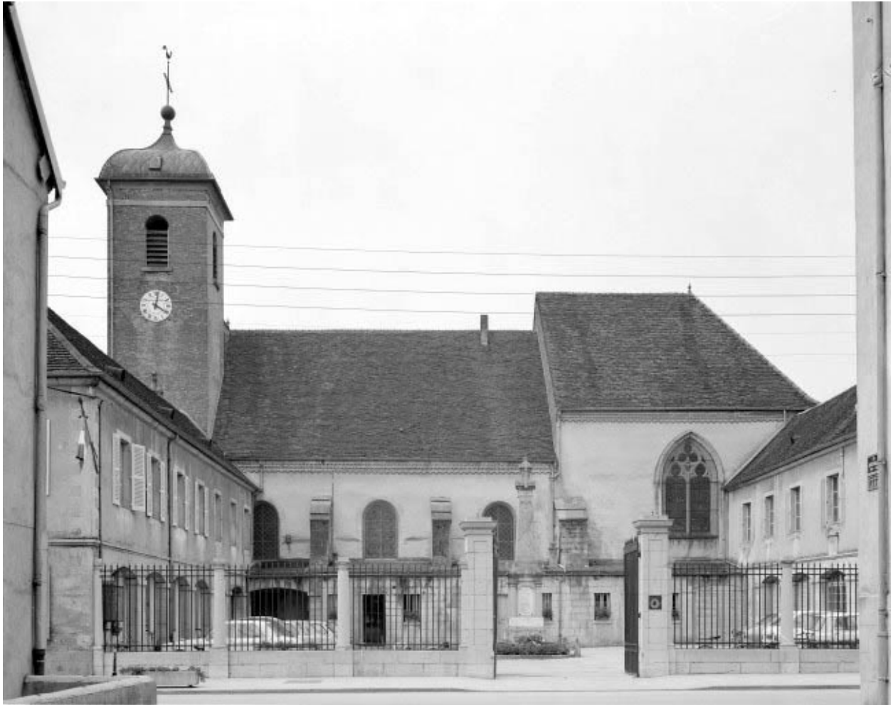
Façade latérale droite.
