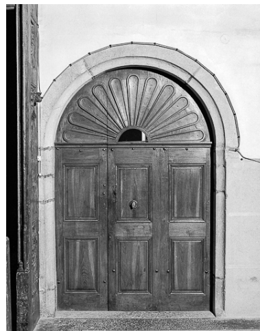
Porte de la sacristie, guichet ouvert. Phot. Yves Sancey IVR43_19753900747X
