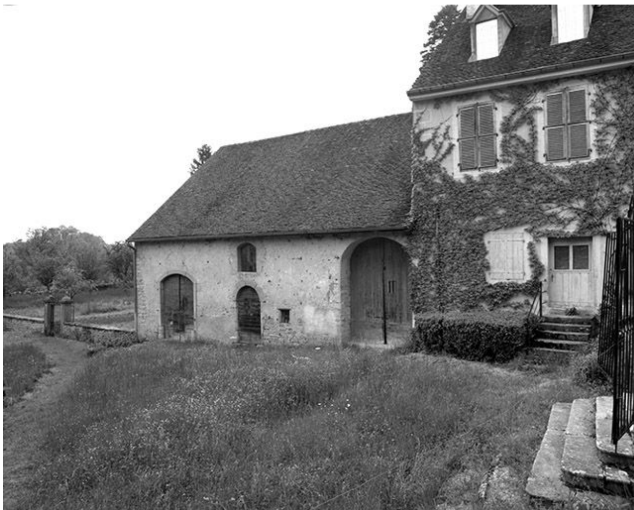
Façade antérieure du logis : partie gauche.
