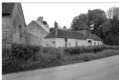
Les communs vus depuis la route. Phot. Jérôme Mongreville IVR43_19853900167X
