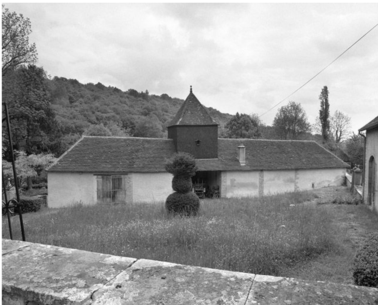
Les communs : façade postérieure.
