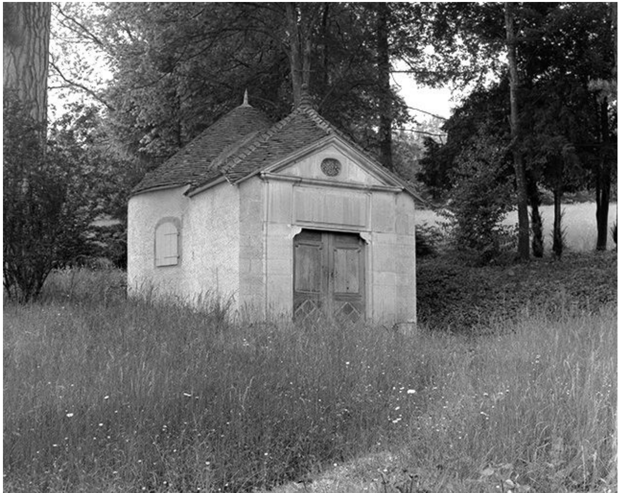
Chapelle dans le parc : vue d'ensemble.
