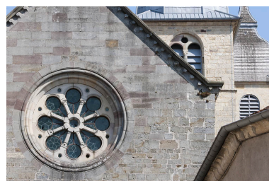
Façade antérieure, détail : l'oculus. Phot. Jérôme Mongreville IVR43_20127000072NUC4A
