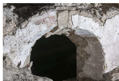
Autre baie en plein cintre au-dessus de la voûte. Phot. Jérôme Mongreville IVR43_20127000790NUC4A
