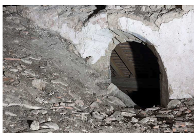
Ancienne baie au-dessus de la voûte. Phot. Jérôme Mongreville IVR43_20127000789NUC4A
