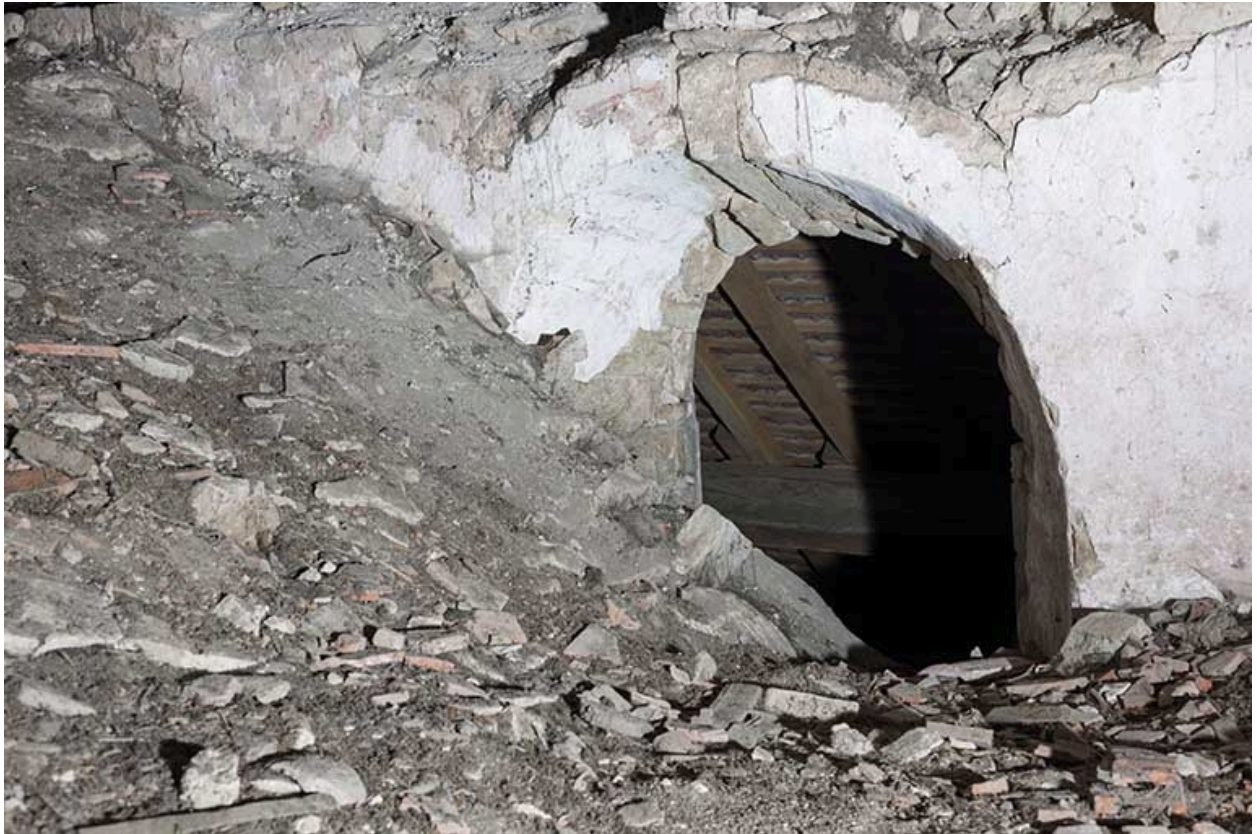
Ancienne baie au-dessus de la voûte.
