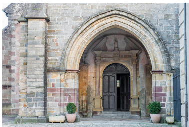
Vue rapprochée du porche. Phot. Mary Ruffinoni IVR43_20127000273NUC4A
