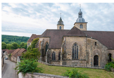
Vue du chevet et de l'élévation nord depuis la rue de l'Official. Phot. Jérôme Mongreville IVR43_20157000113NUC4A
