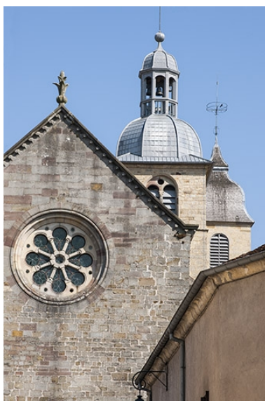
Façade antérieure, détail : l'oculus et au second plan les deux tours du clocher. Phot. Jérôme Mongreville IVR43_20127000786NUC4A
