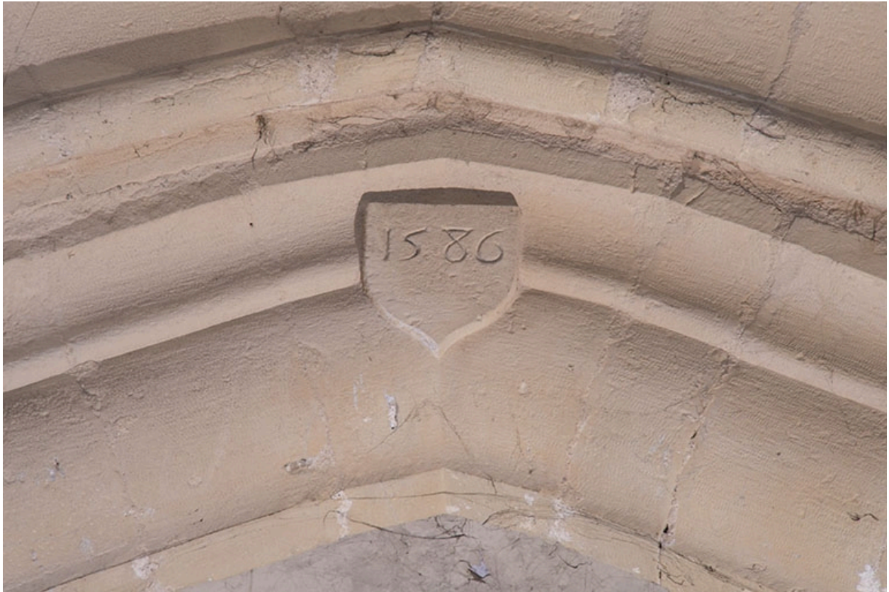
Arc brisé à la jonction du choeur et du transept : écu portant la date gravée 1586.
