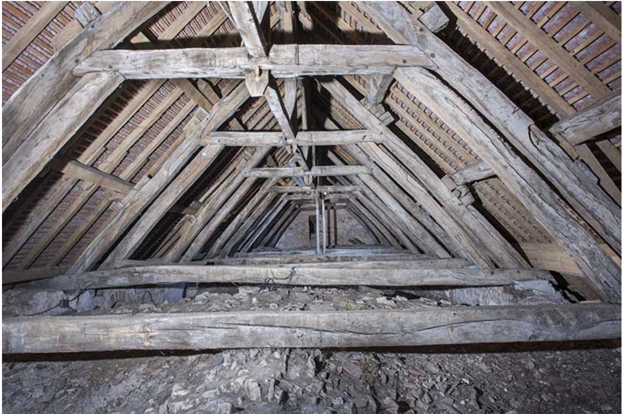
Vue d'ensemble de la charpente.
