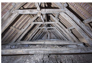
Vue d'ensemble de la charpente. Phot. Jérôme Mongreville IVR43_20127000791NUC4A
