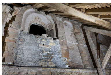
Baie en plein cintre vue depuis le comble du bas-côté sud. Phot. Mary Ruffinoni IVR43_20127000347NUC4A
