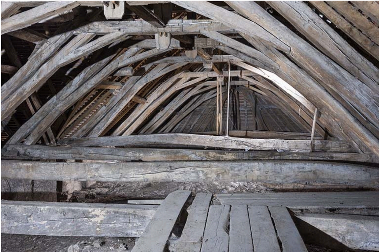
Autre vue de la charpente.
