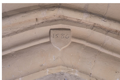
Arc brisé à la jonction du choeur et du transept : écu portant la date gravée 1586. Phot. Mary Ruffinoni IVR43_20127000250NUC4A
