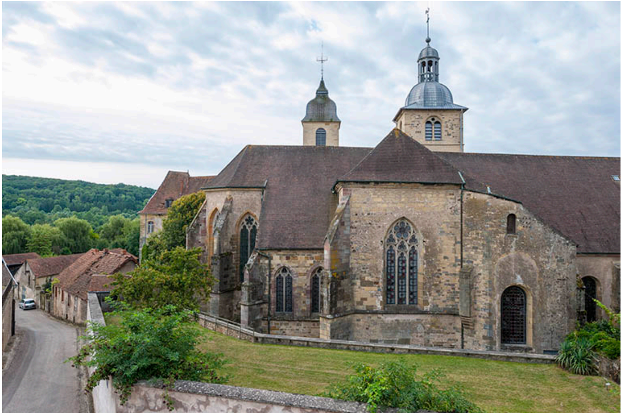
Vue du chevet et de l'élévation nord depuis la rue de l'Official.
