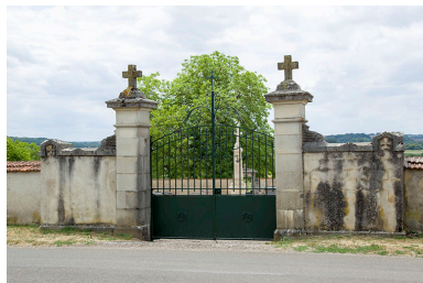
Entrée rue de Tincey. Phot. Sonia Dourlot IVR43_20157000352NUC2A
