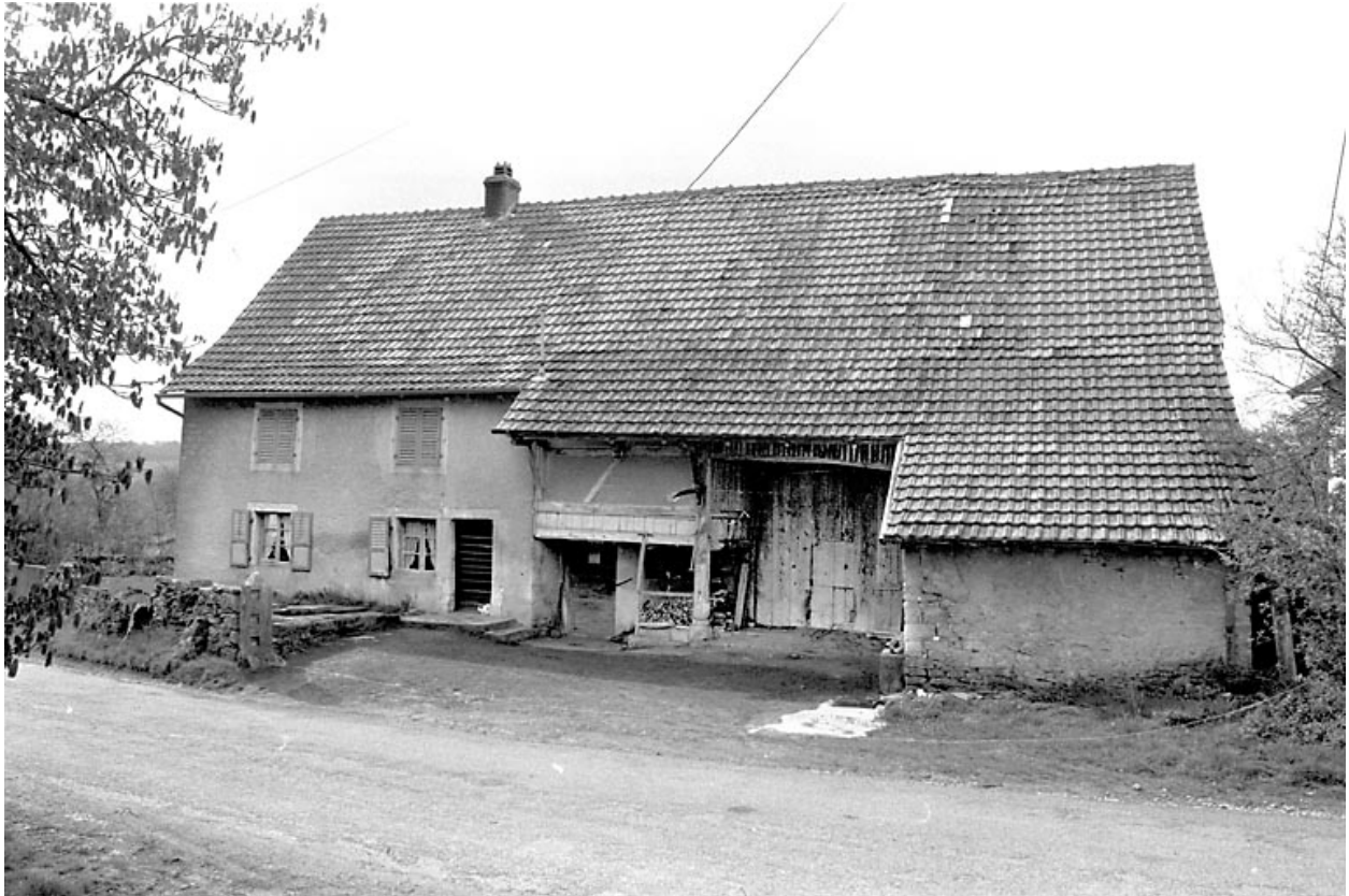
Façade antérieure sur rue.
