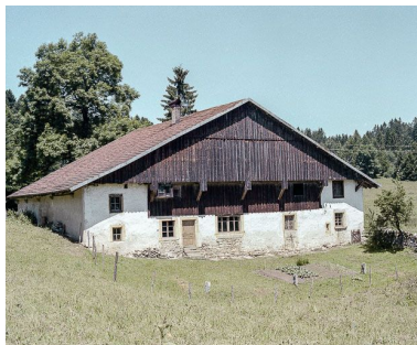
Ferme située au lieudit Les Bécus : façade antérieure.
