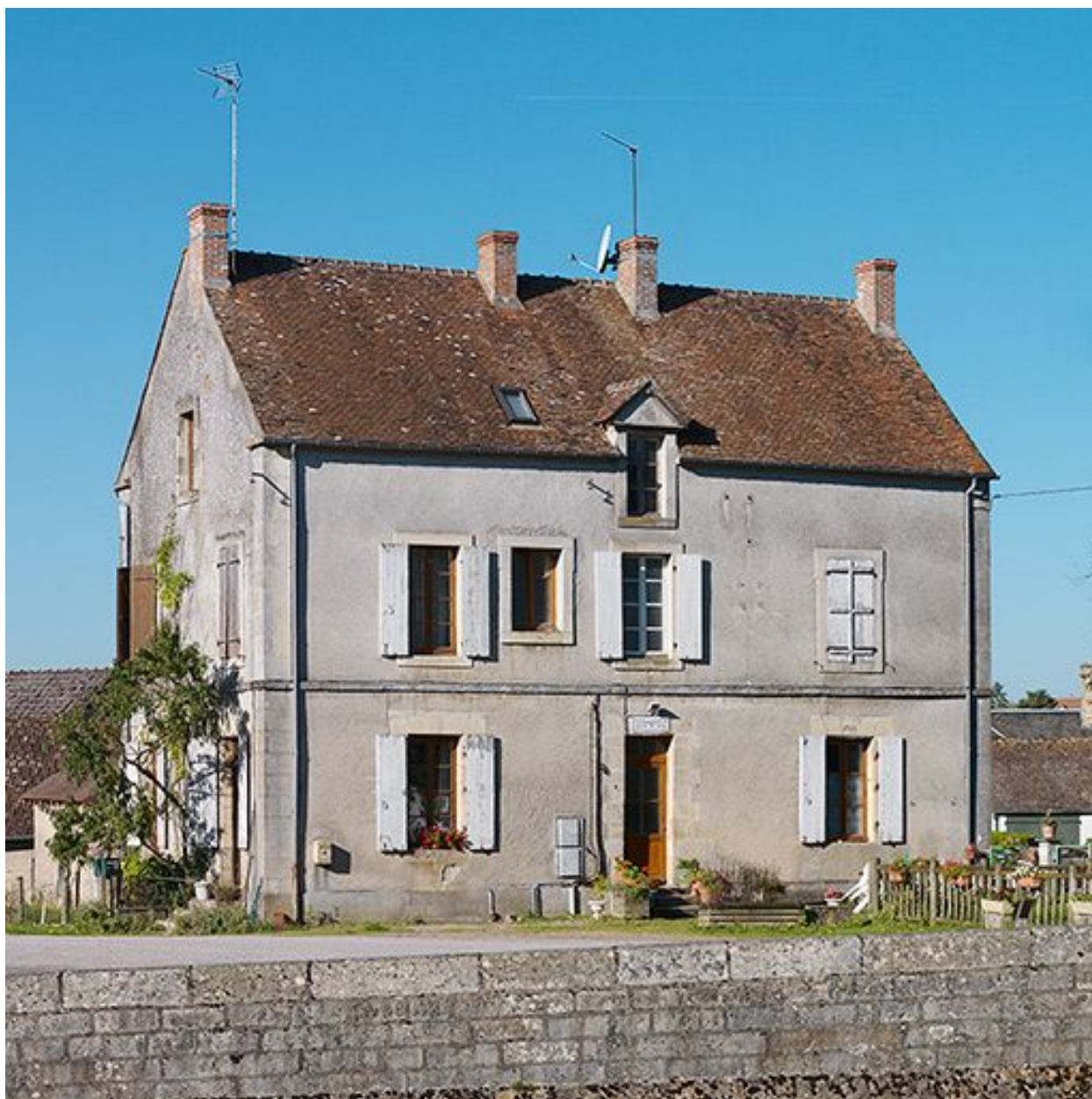
La maison éclusière de face.
