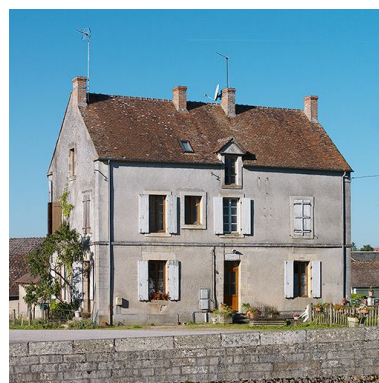
La maison éclusière de face.
