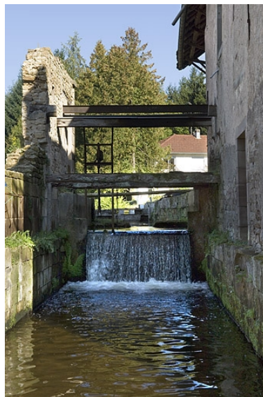
Bief de dérivation depuis l'aval. Phot. Jérôme Mongreville IVR43_20067000880NUCA
