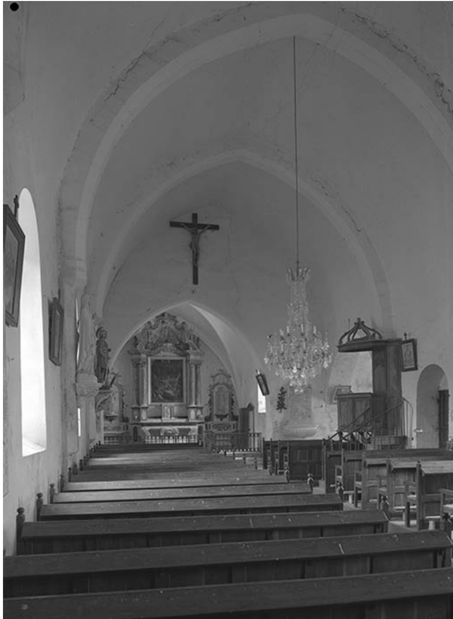
Vue intérieure vers le chœur.
