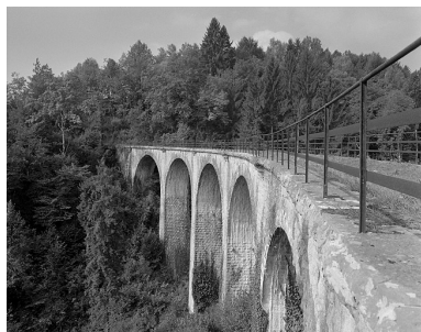
Les cinq arches du viaduc. Phot. Jérôme Mongreville IVR43_19963900961X
