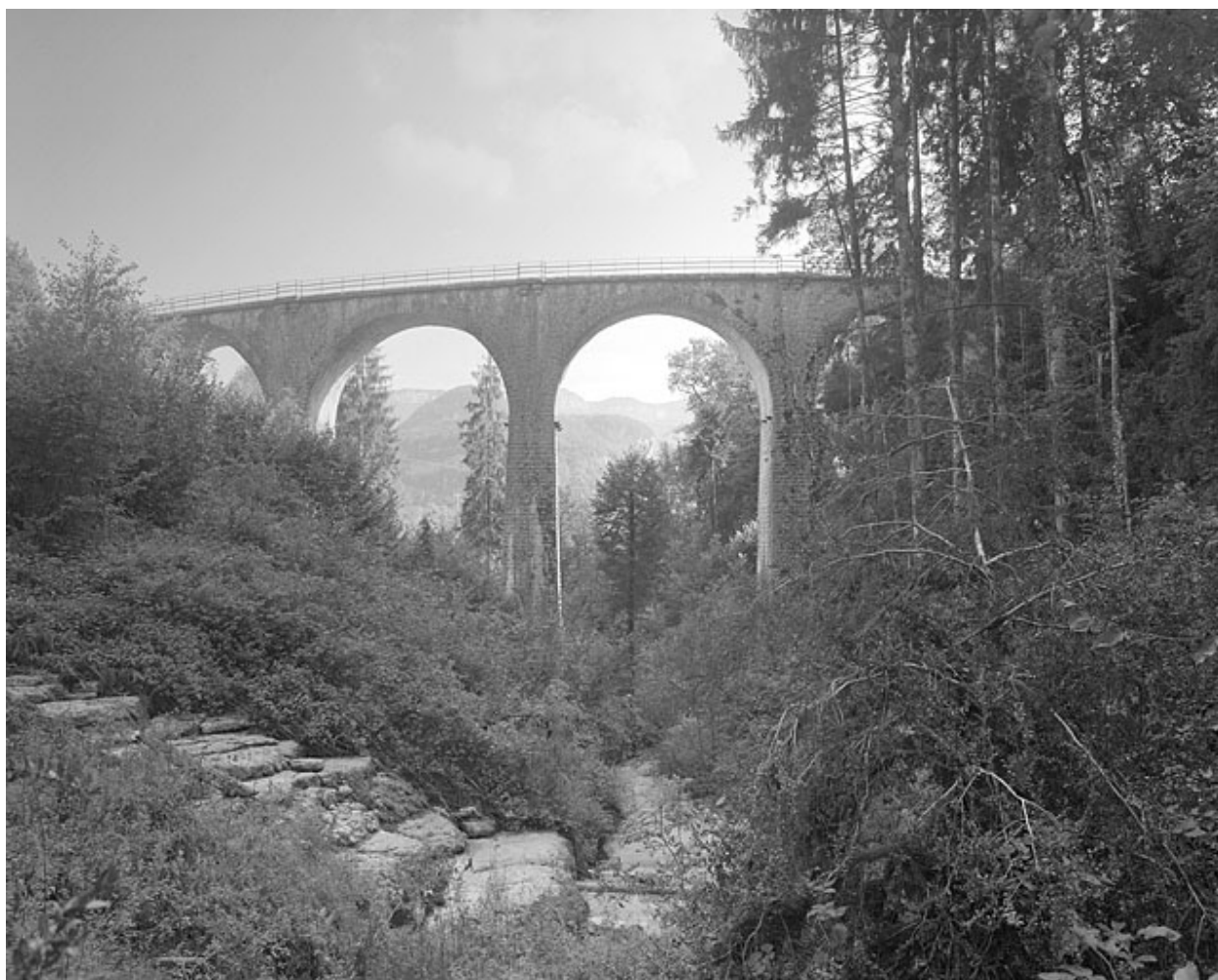
Le viaduc depuis le ruisseau du Nans.
