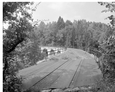
Tablier du viaduc. Phot. Jérôme Mongreville IVR43_19963900962X
