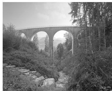
Le viaduc depuis le ruisseau du Nans. Phot. Jérôme Mongreville IVR43_19963900956X
