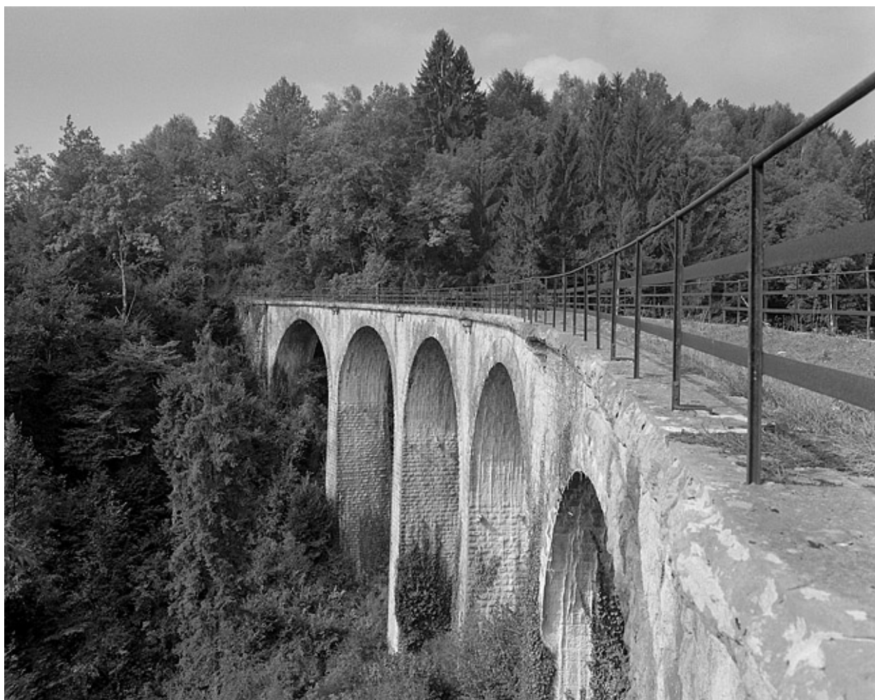
Les cinq arches du viaduc.
