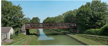
Vue du pont.
