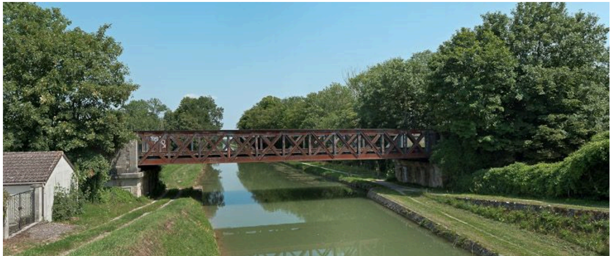
Vue du pont.
