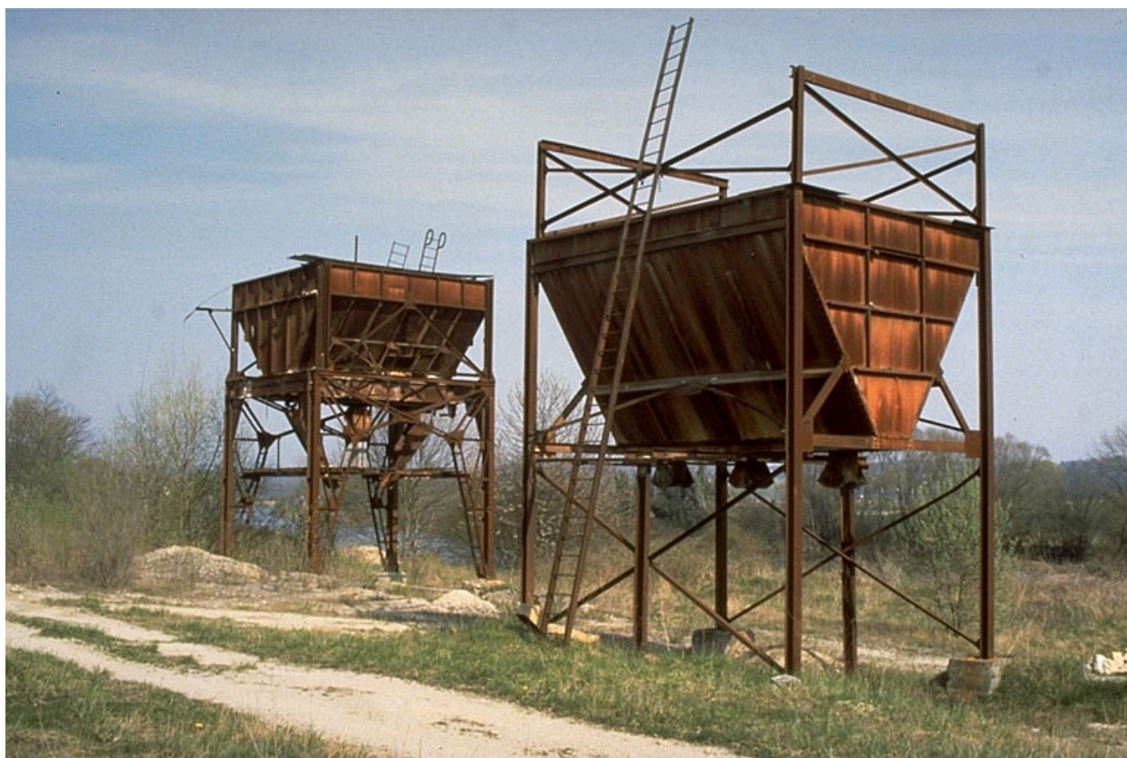
Trémies du poste de chargement.
