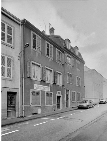
Façade sur la rue du Château. Phot. Jérôme Mongreville IVR43_19882500194V
