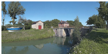
Vue d'ensemble prise d'aval.
