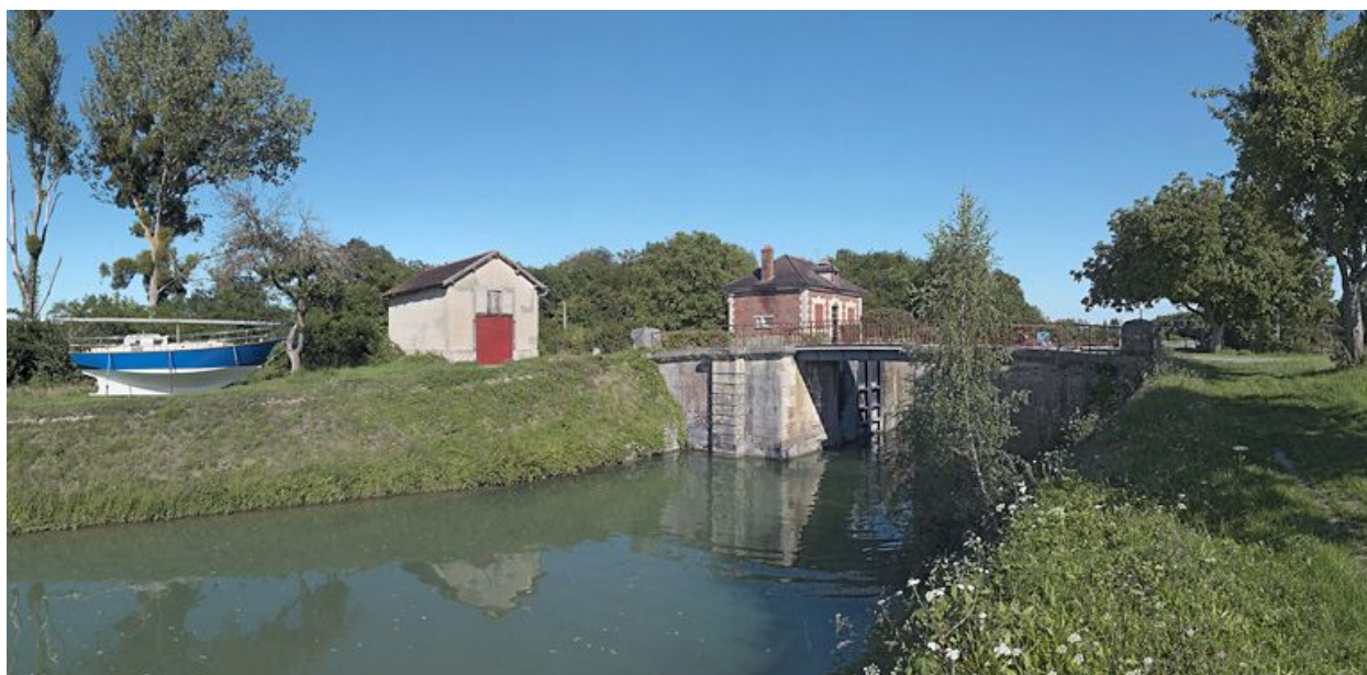
Vue d'ensemble prise d'aval.
