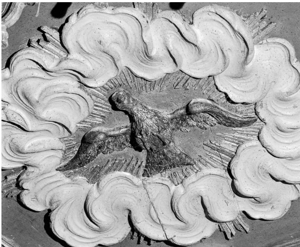
Détail : plafond de l'abat-voix.
