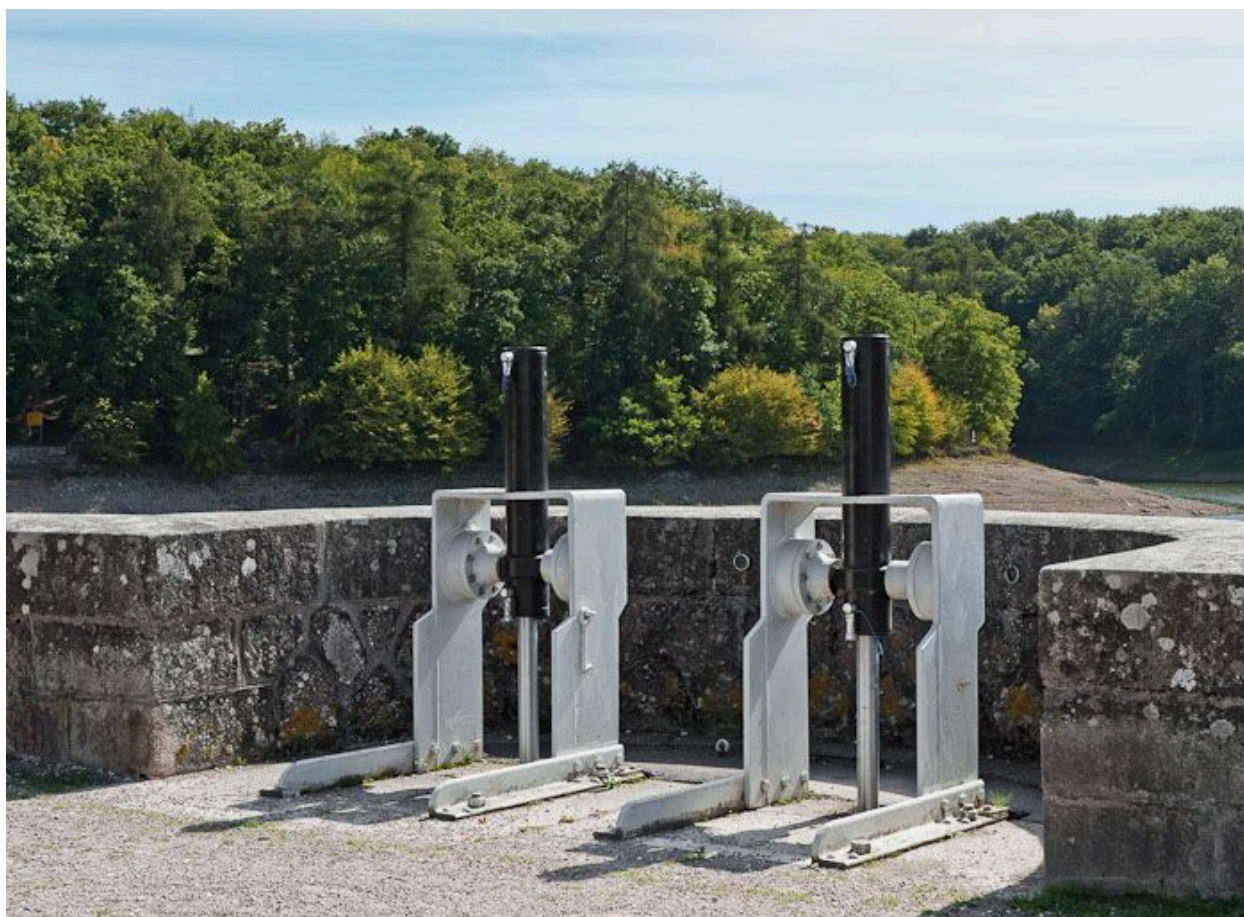
Vue des vannes de la tour de prise d'eau.
