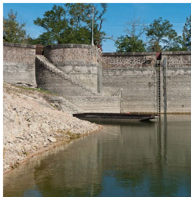
Vue de la tour de prise d'eau. Phot. Pierre-Marie Barbe-Richaud IVR26_20112103616NUC2AQ
