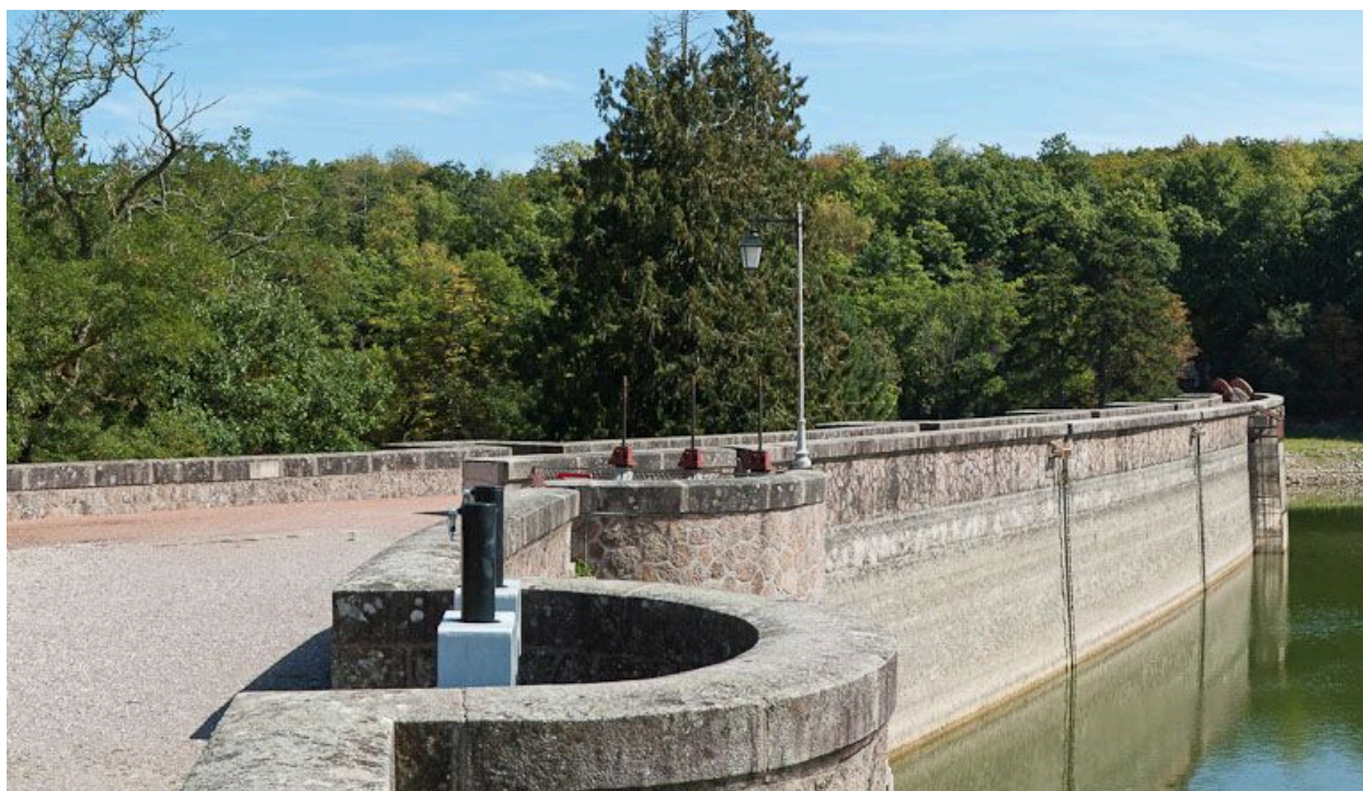
Vue de la digue du réservoir.
