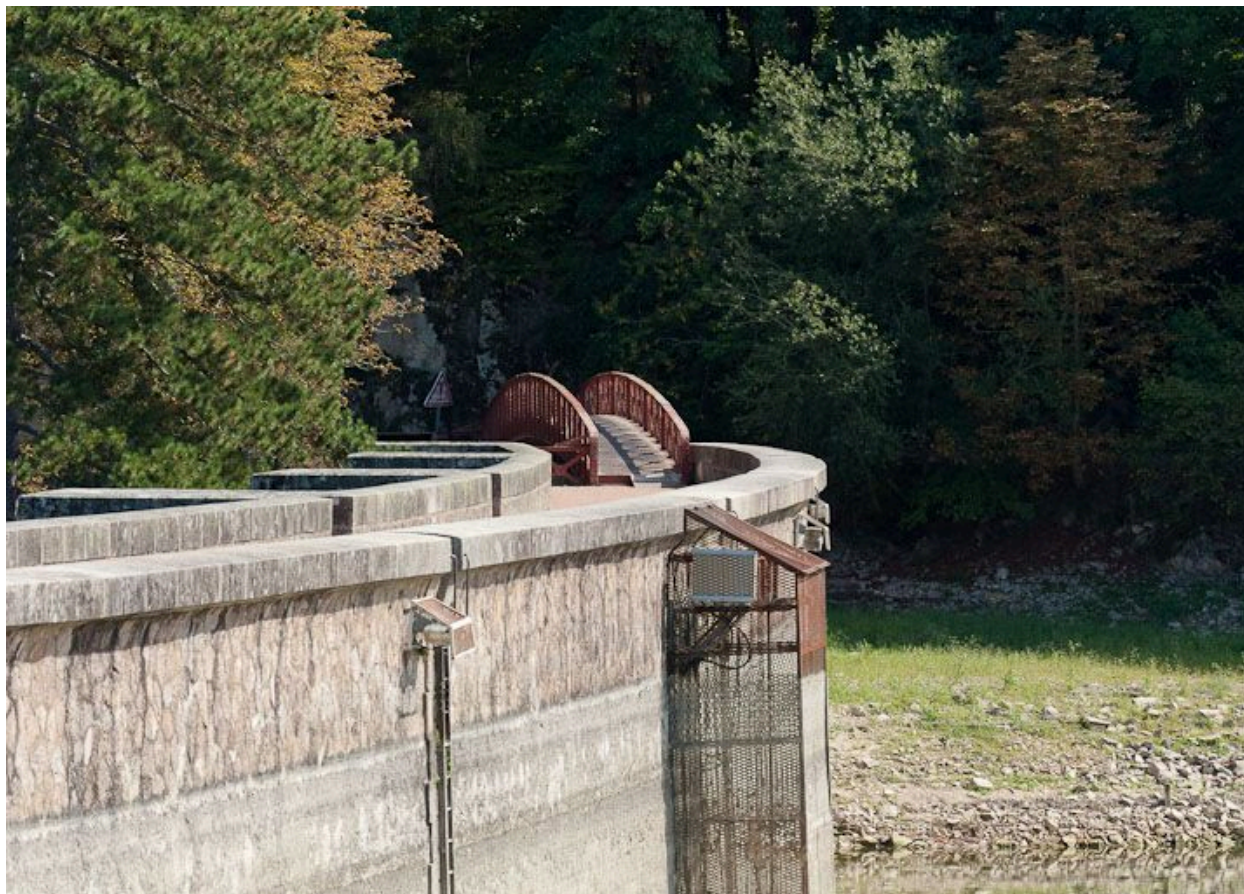
Vue de la digue du réservoir.
