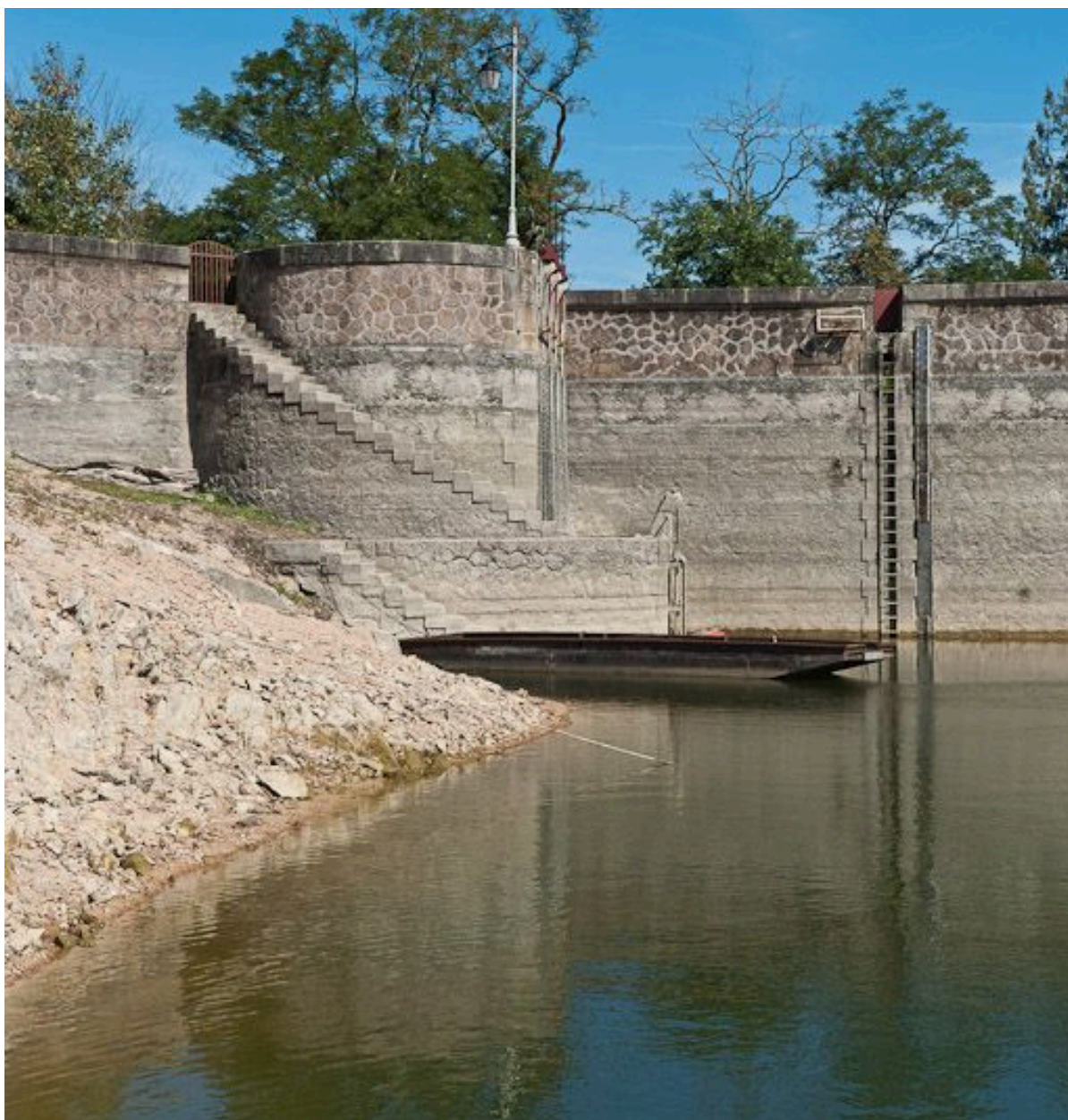
Vue de la tour de prise d'eau.
