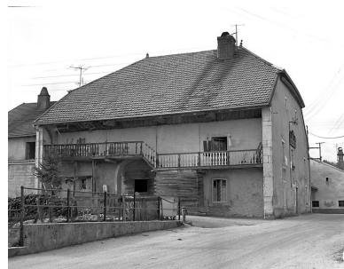
Ferme située 5 Grande Rue. Phot. Dominique Dominguez IVR43_19792501031X
