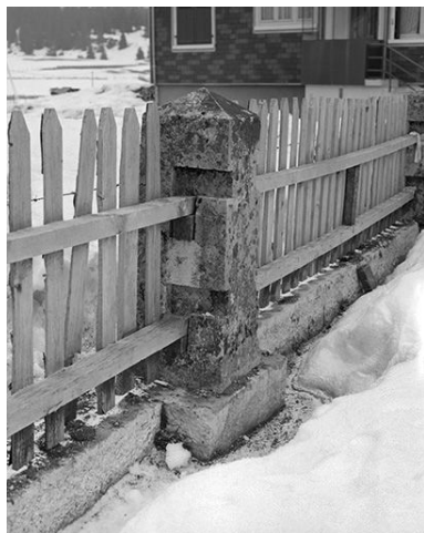
Ferme voisine de la ferme dite "Le Château" : détail de la clôture du jardin-potager. Phot. Dominique Dominguez IVR43_19802500097X
