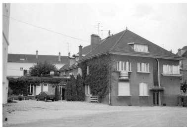
Logement patronal, vu depuis la cour. Phot. Laurent Poupard IVR43_19893900218Z
