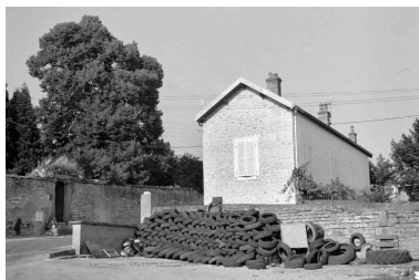
Logement de contremaître. Phot. Laurent Poupard IVR43_19893900221Z
