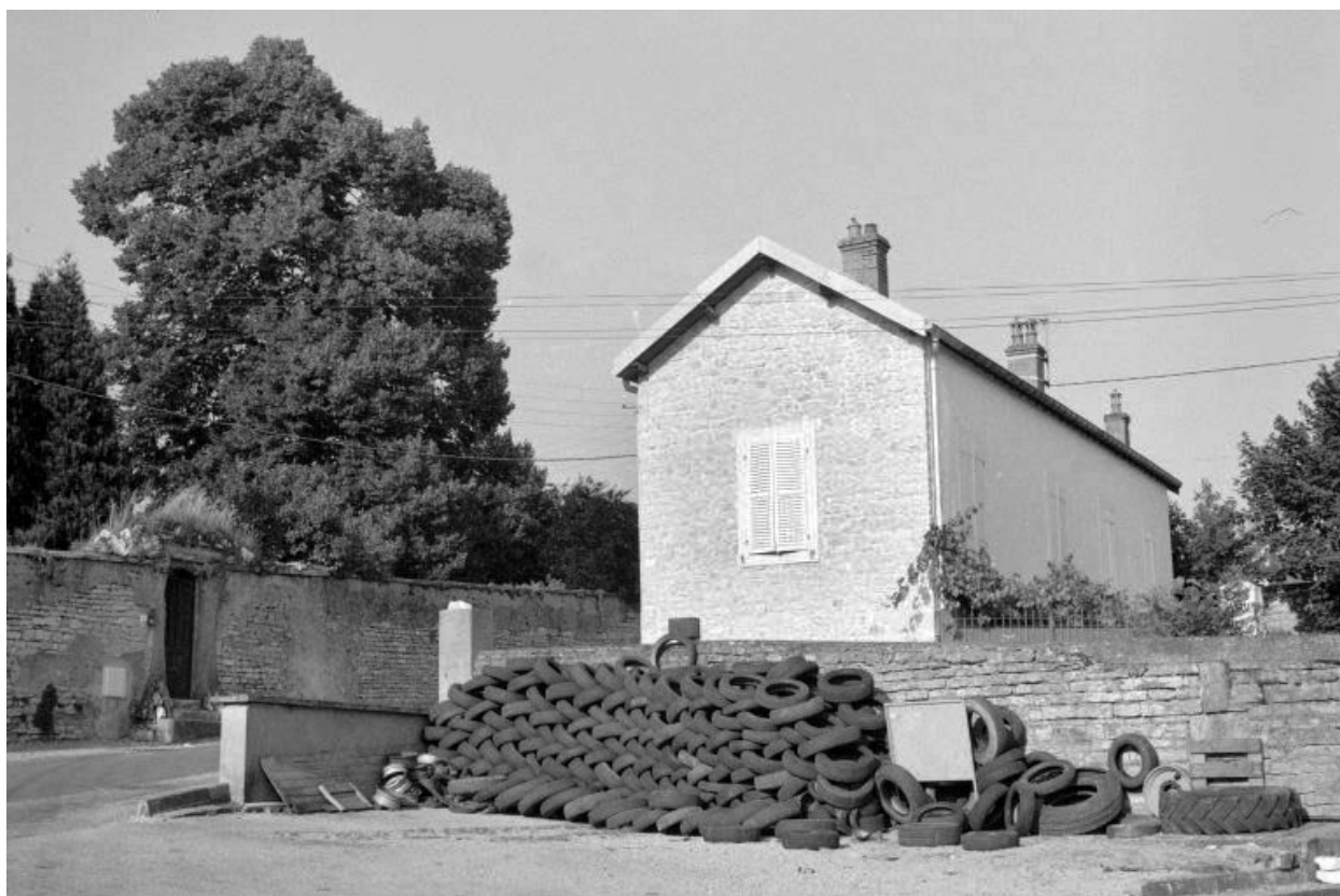
Logement de contremaître.
