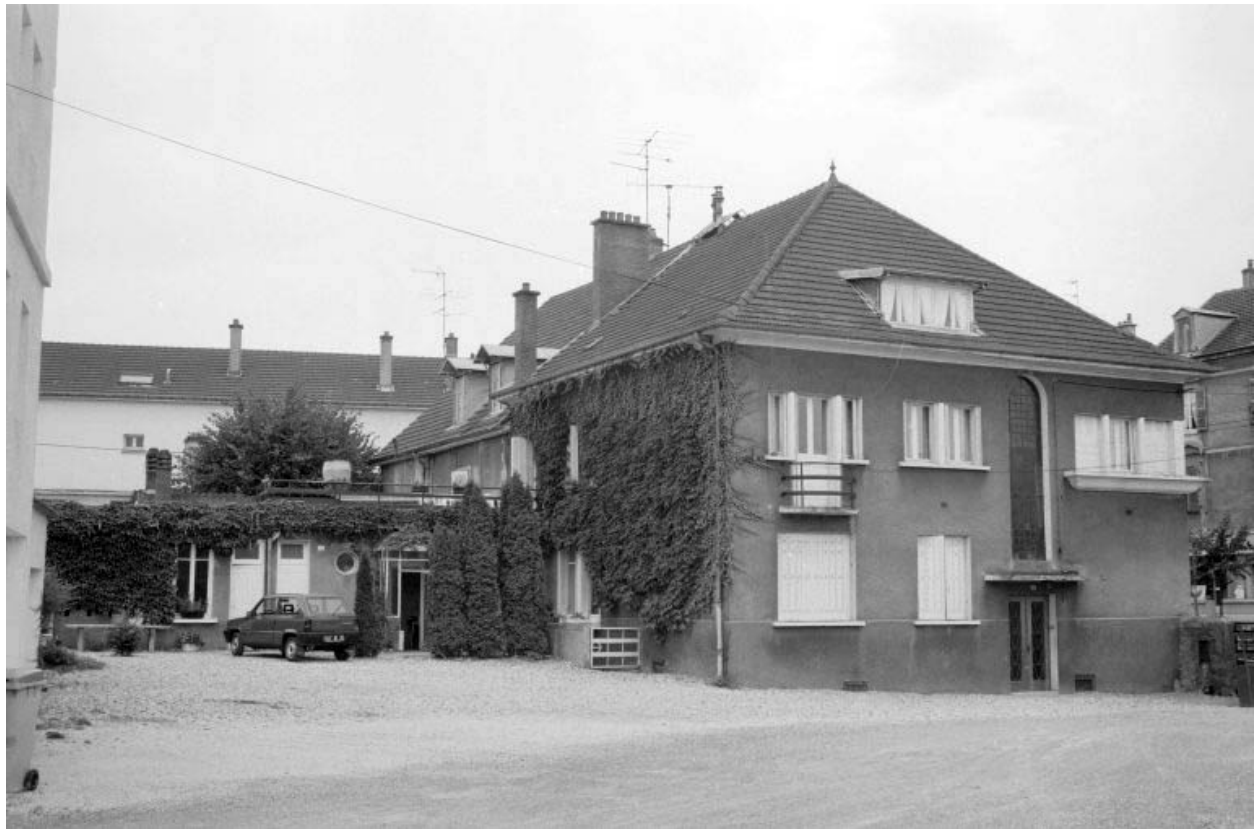
Logement patronal, vu depuis la cour.
