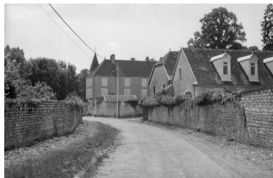
Vue d'ensemble depuis la rue. Phot. Bernard Lardière IVR43_19817000454Z
