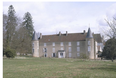
Façade sur parc. Phot. Yves Sancey IVR43_19857000072XA
