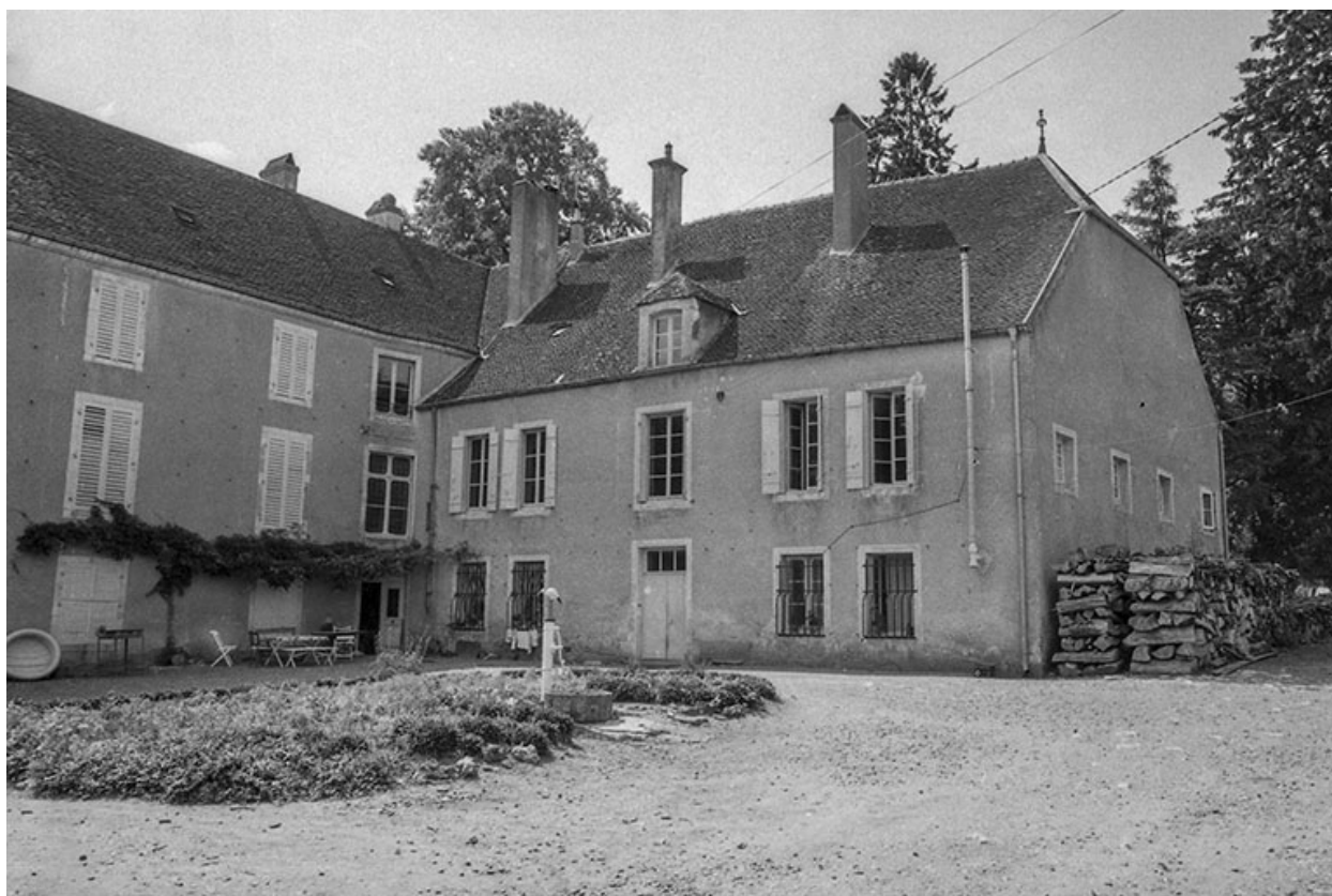
Vue de l'habitation depuis la cour.
