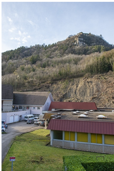
Site du casino (détruit), actuellement occupé par le centre hospitalier. Phot. Jérôme Mongreville IVR43_20213900242NUC4A
