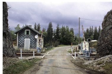
Façade sud (côté voie). Phot. Yves Sancey IVR43_20043900278ZA
