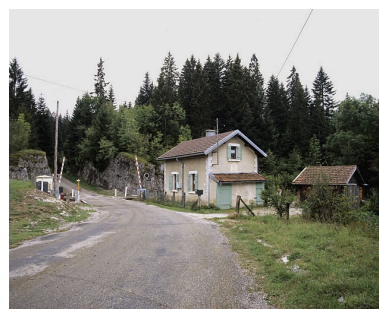
Vue d'ensemble, depuis le nord. Phot. Yves Sancey IVR43_20043900274XA
