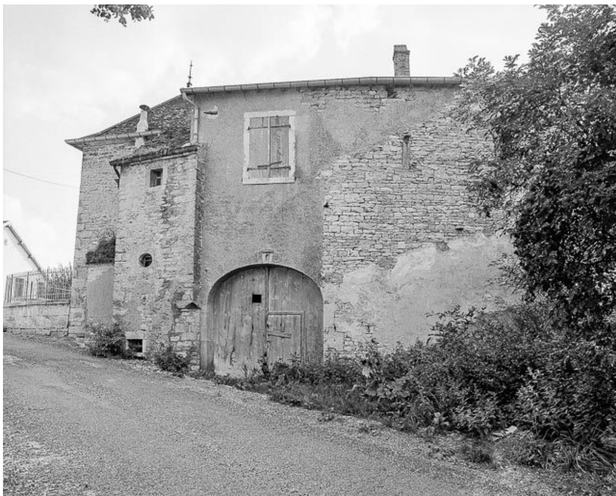
Vue rapprochée de la façade latérale droite.
