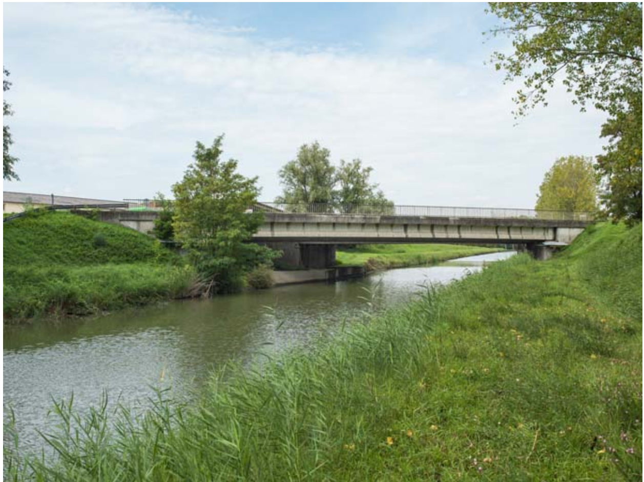
Vue d'ensemble du pont.
