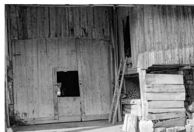
Ferme située à Sombacour : porte de grange et galerie en bois fermée servant de bûcher. Phot. Gilbert Poinot IVR43_19752501441Z
