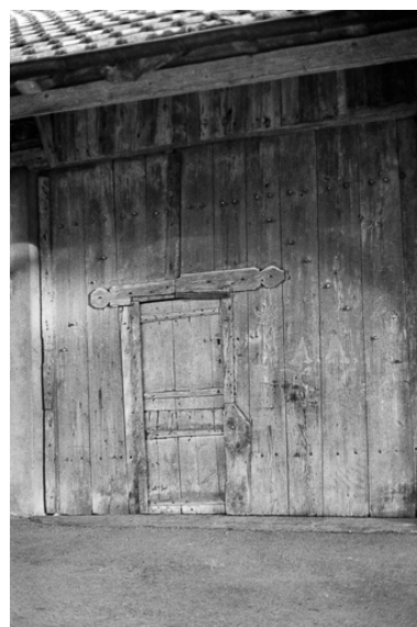
Ferme située à Bulle : porte de grange. Phot. Gilbert Poinot IVR43_19752501406Z
