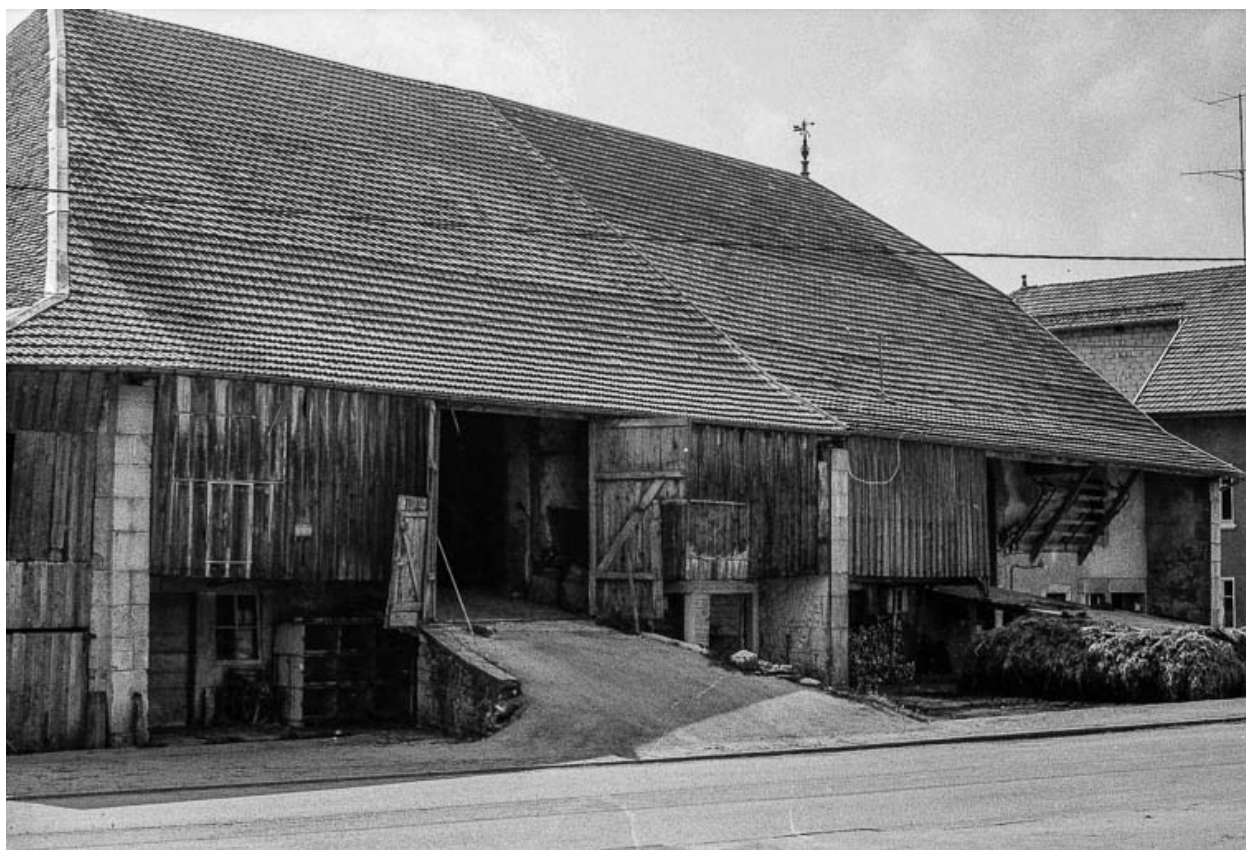
Ferme située à Evillers : murs à long-pan sur rue.
