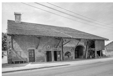
Ferme située à Sombacour : façade sur rue. Phot. Gilbert Poinot IVR43_19752501492Z
