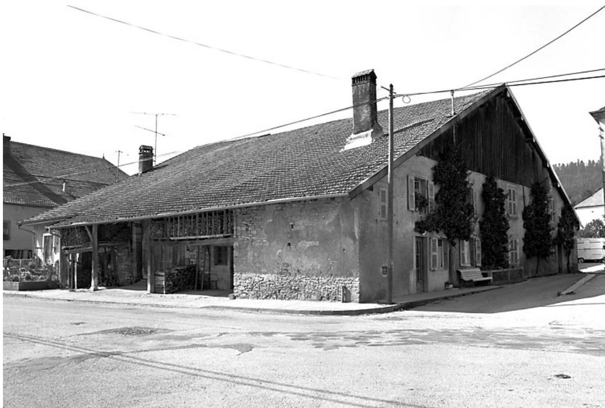
Ferme située à Evillers : pignon d'habitation et gouttereau sur rue.
