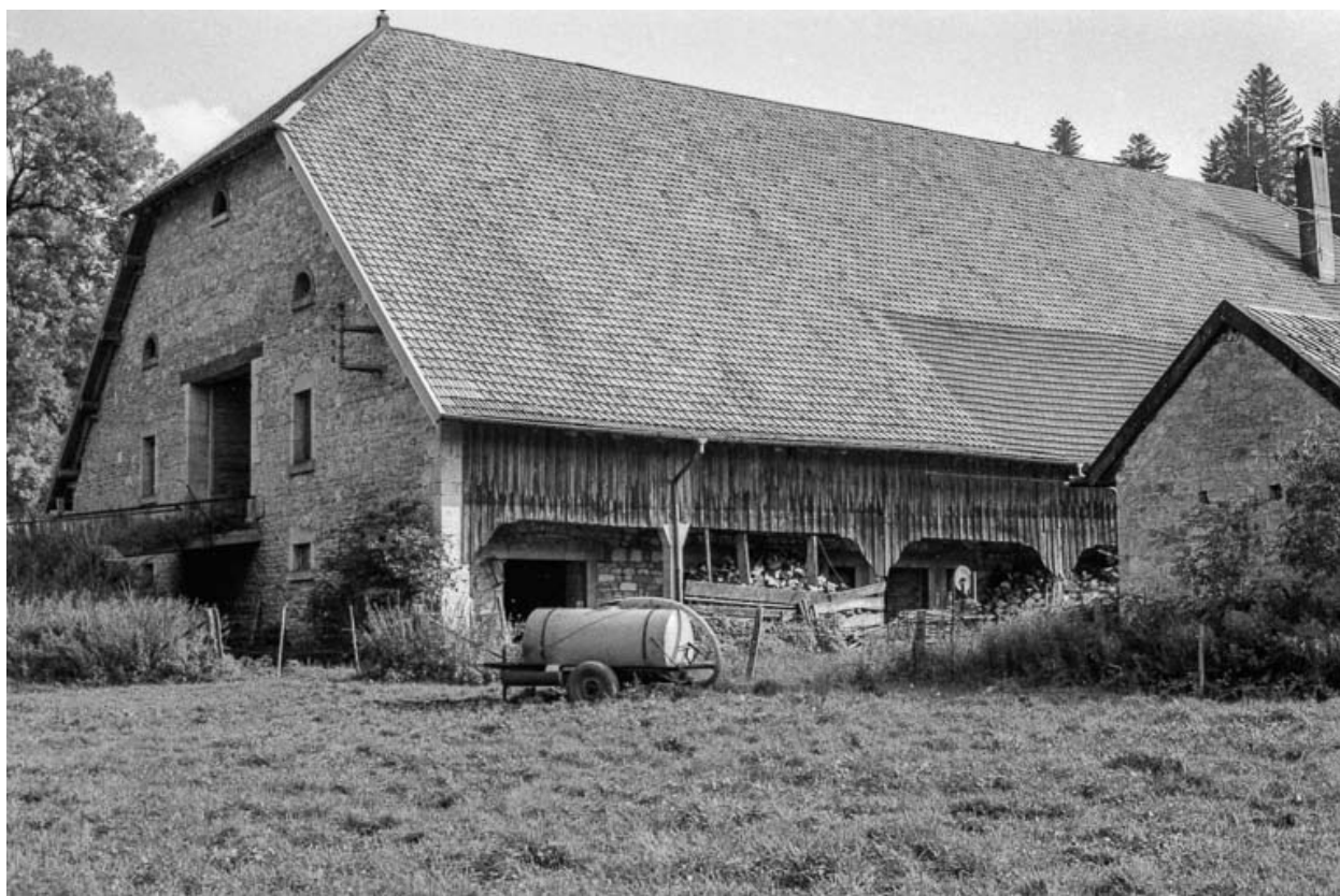
Ferme située à Levier : montée de grange haute sur pignon et fermeture d'avant-toit sur long-pan.
