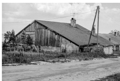
Ferme située à Boujailles : façades latérale et postérieure avec débord de la partie habitation, pignon fermé par des planches et montée de grange. Phot. Gilbert Poinot IVR43_19752500769Z
