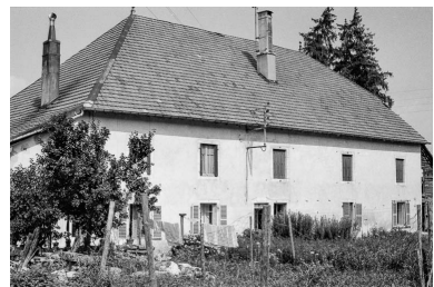
Bians-les-Usiers : ferme Phot. Gilbert Poinot IVR43_19752501448Z
