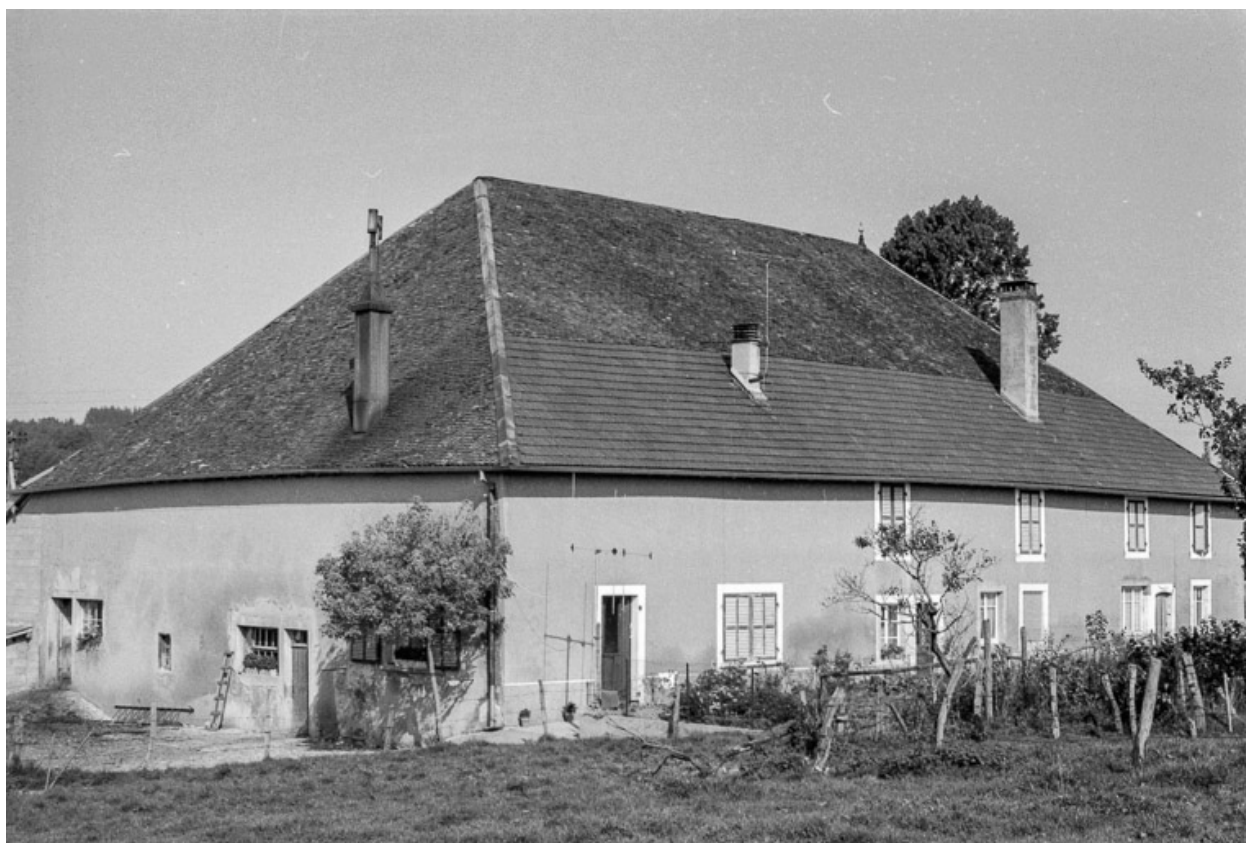
Ferme située à Villeneuve-d'Amont : façade habitation sur long-pan.
