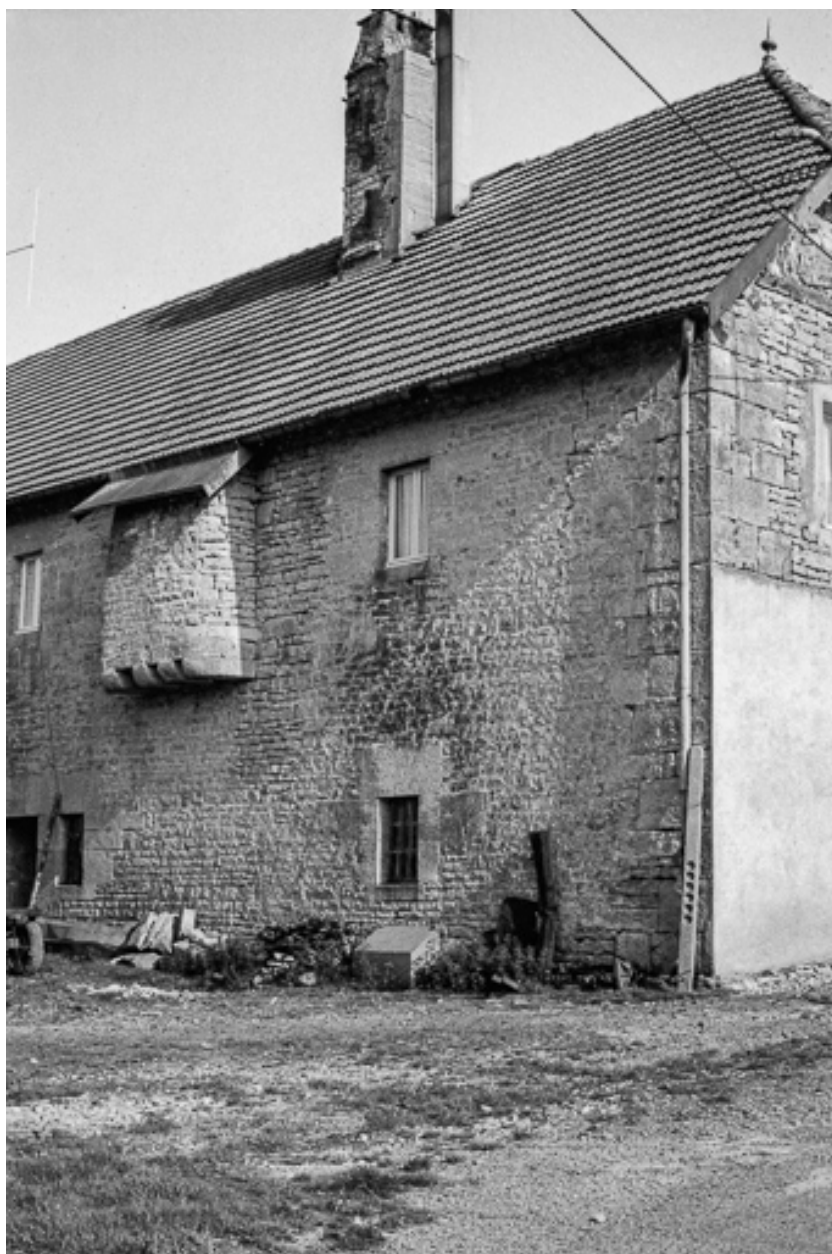
Ferme située à Villeneuve d'Amont : cul-du-four extérieur suspendu.
