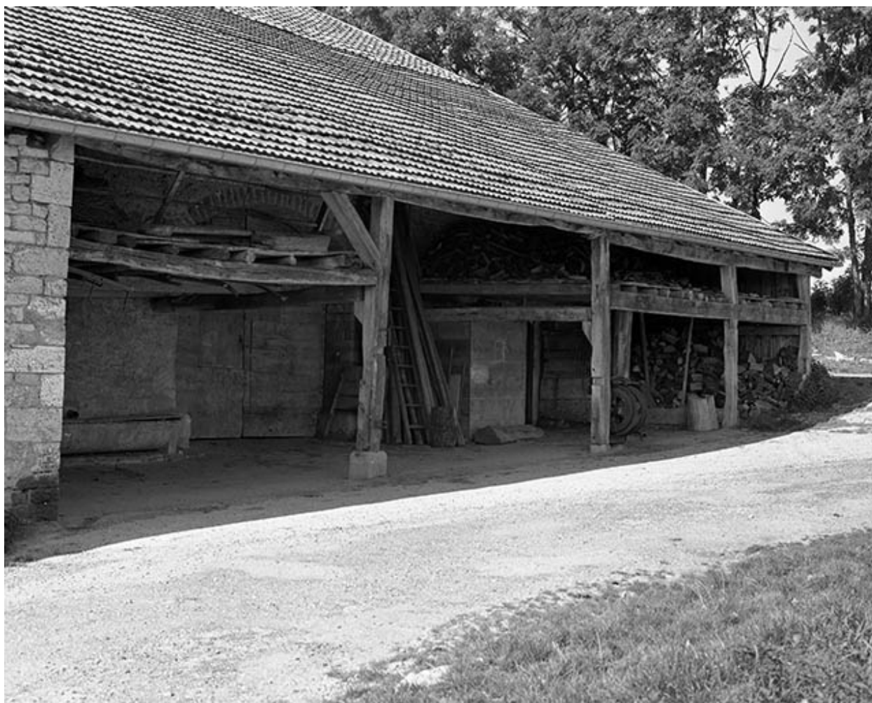
Ferme située à Septfontaines : auvent sur mur gouttereau et entrée de grange appareillée.
