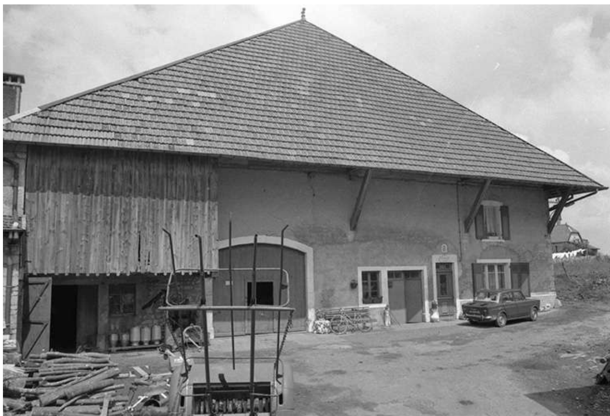
Dompierre-les-Tilleuls : ferme située rue de la Chapelle.
