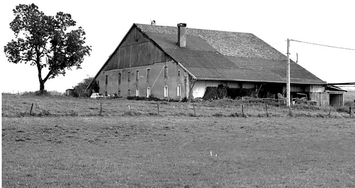
Ferme située à Boujailles : grosse ferme destinée à deux cellules familiales, typique du canton.
