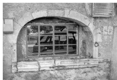
Ferme située à Sombacour : fenêtre de l'écurie et petite mangeoire à chevaux extérieure. Phot. Gilbert Poinot IVR43_19752501466Z
