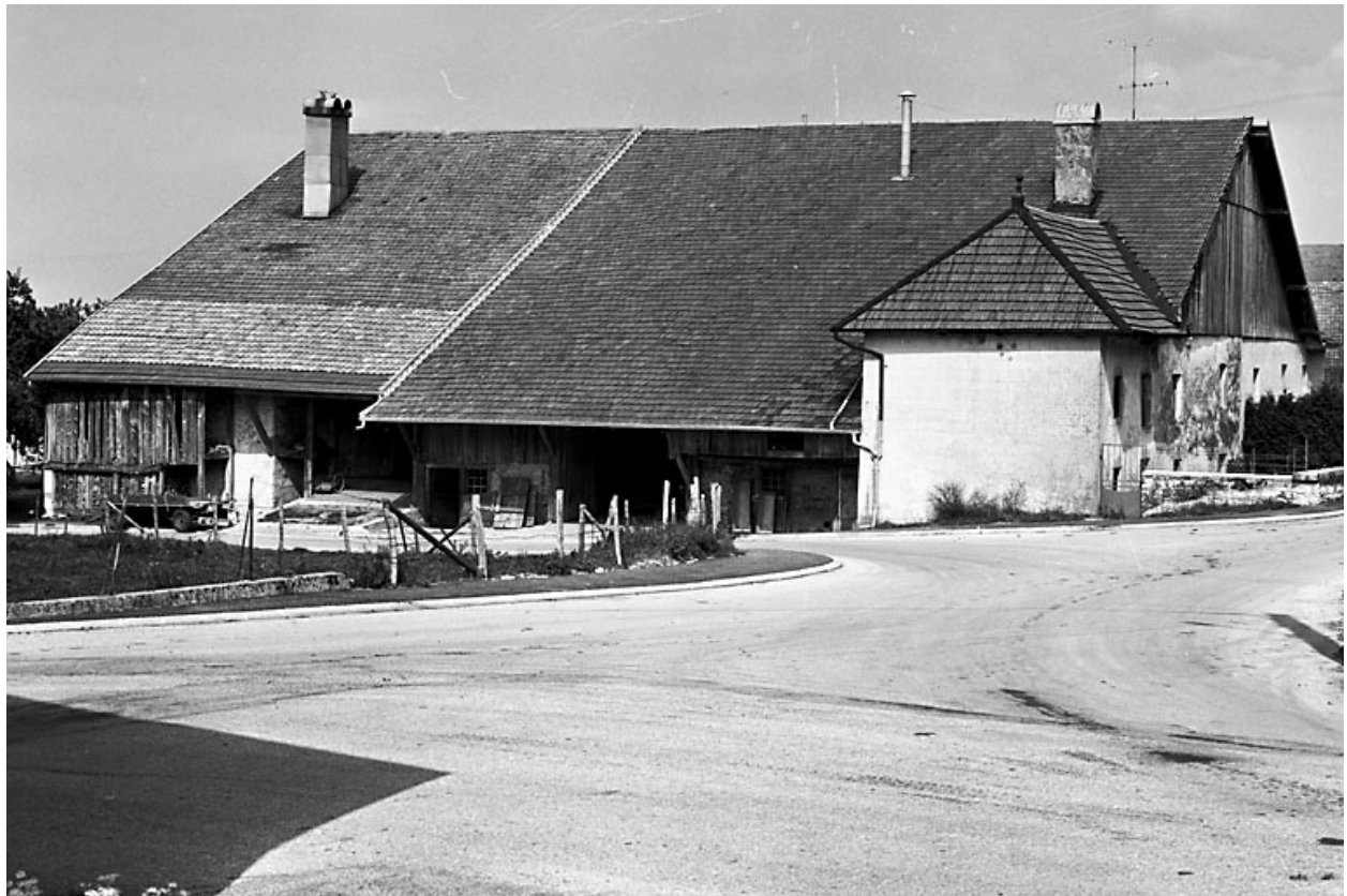
Ferme située à Goux-les-Usiers : rez-de chaussée enterré au sommet de la pente profitant d'un ensoleillement maximum.
