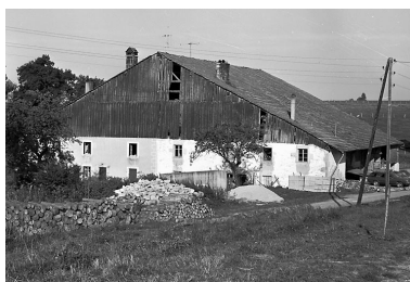
Bians-les-Usiers : ferme double avec montée de grange sur le gouttereau. Phot. Bernard Lardière IVR43_19782500316X
