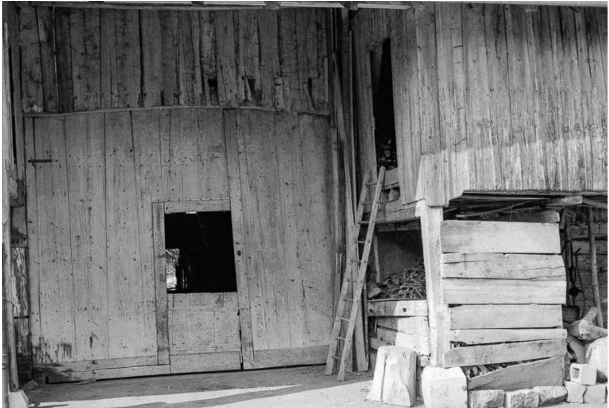
Ferme située à Sombacour : porte de grange et galerie en bois fermée servant de bûcher.
