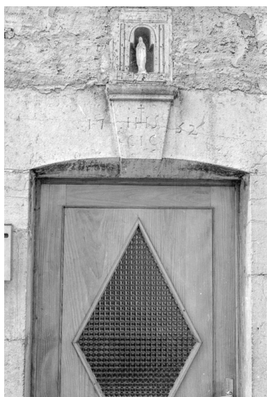
Ferme située à Septfontaines : inscriptions et dates sur linteau de porte, niche. Phot. Gilbert Poinot IVR43_19752501280Z
