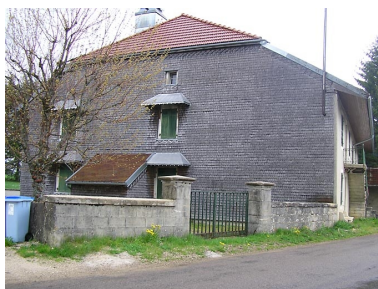
Pignon sud-ouest. Phot. Marie-Pierre Reynet IVR43_20083900380NUC1A
