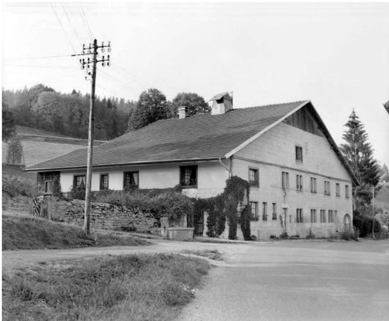
Façades antérieure et latérale gauche.
