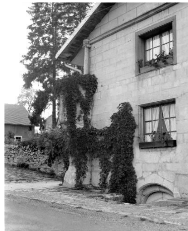
Façade antérieure : partie gauche avec contrefort et entrée de cave. Phot. Dominique Humbert IVR43_19762500679X
