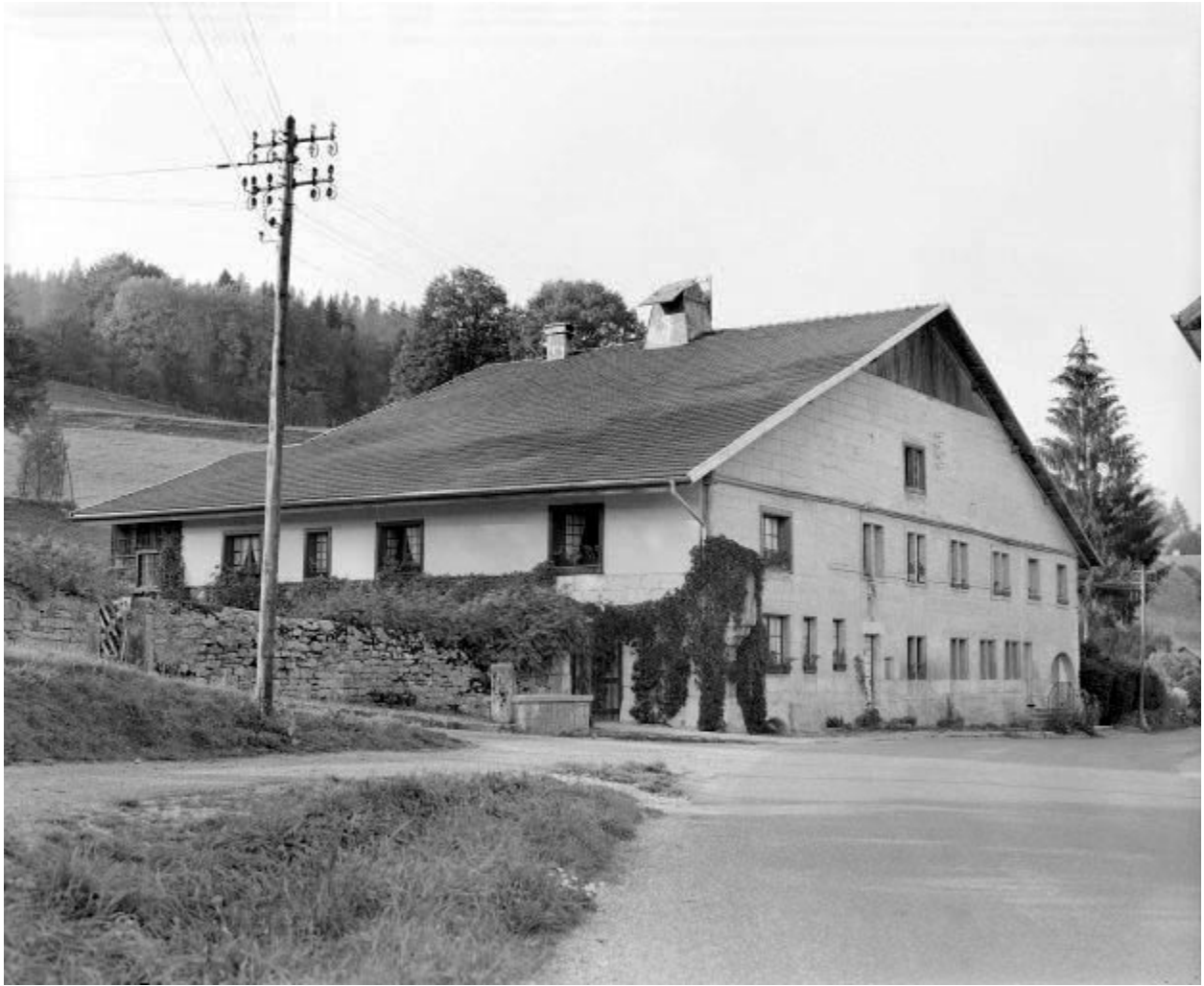
Façades antérieure et latérale gauche.
