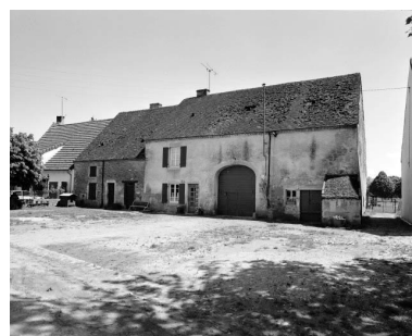
Ferme située rue Neuve : façade antérieure. Phot. Bernard Lardière IVR43_19793900348X
