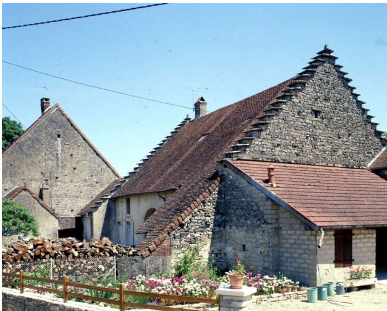
Ferme : façades latérale droite et antérieure.
