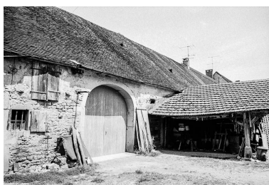
Fermes situées 324-326 rue d'Oisenans : bâtiments d'exploitation. Phot. Bernard Pontefract IVR43_19753900444Z
