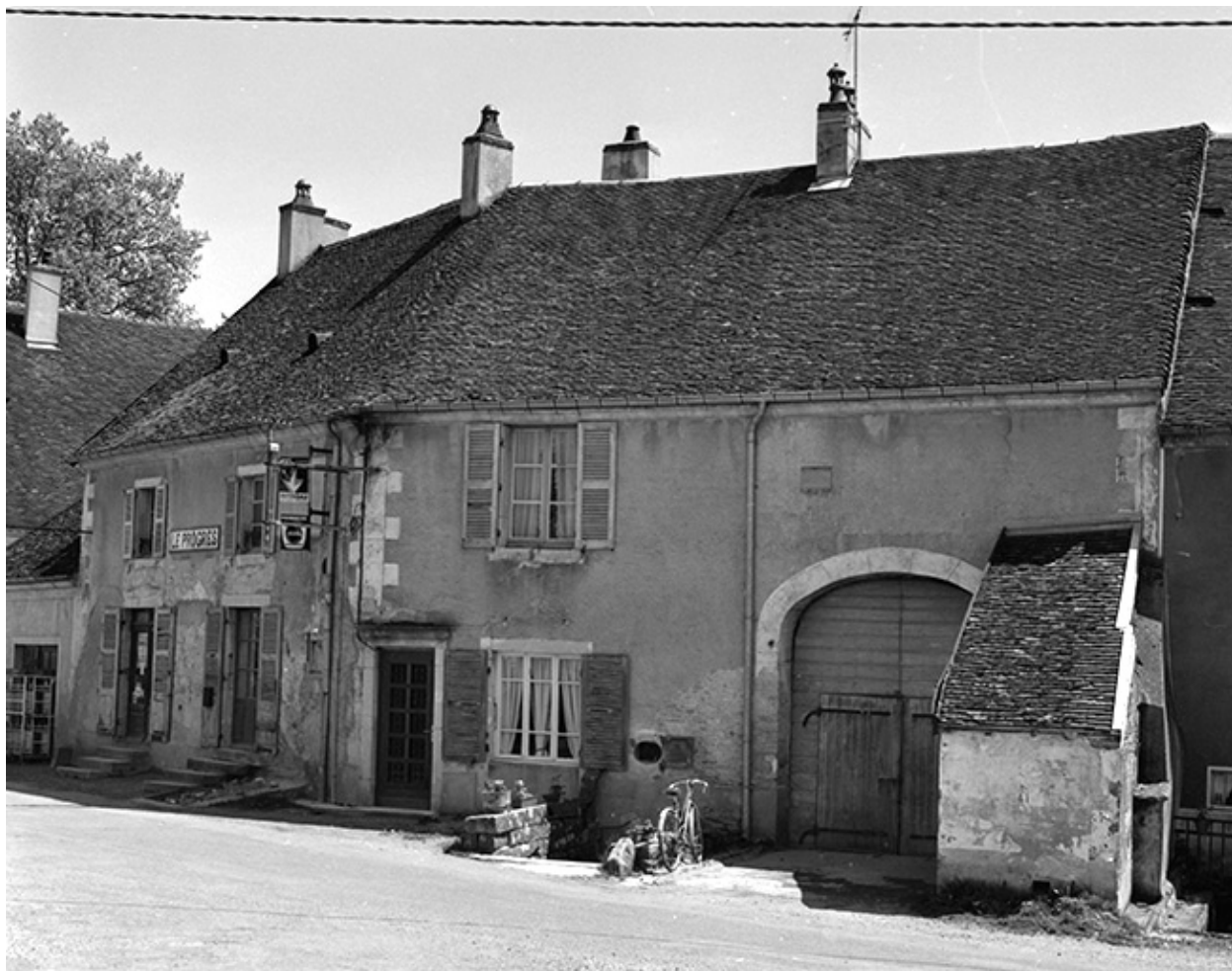
Ferme cadastrée AI 29-30 : façade antérieure, vue rapprochée.
