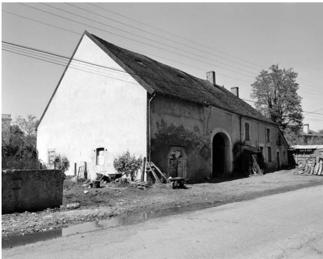
Ferme située rue Neuve : façade antérieure.
