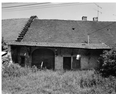
Ferme située rue du Général Gauthier : façade antérieure. Phot. Bernard Lardière IVR43_19793900347X
