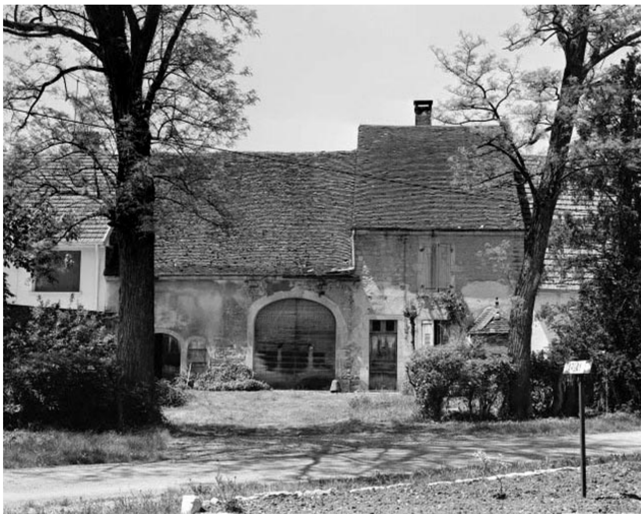
Ferme située rue du Raffour : façade antérieure.
