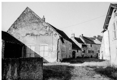
Maisons cadastrées 1960 AI 97 à 101, situées rue du Puits : vue d'ensemble. Phot. Bernard Pontefract IVR43_19753900426Z
