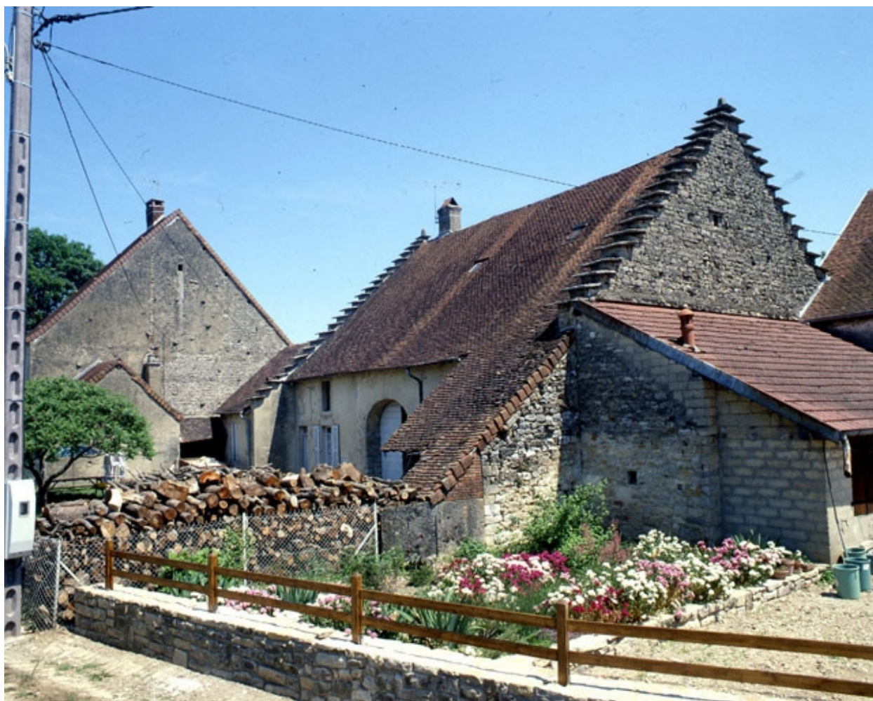
Ferme : façades latérale droite et antérieure.
