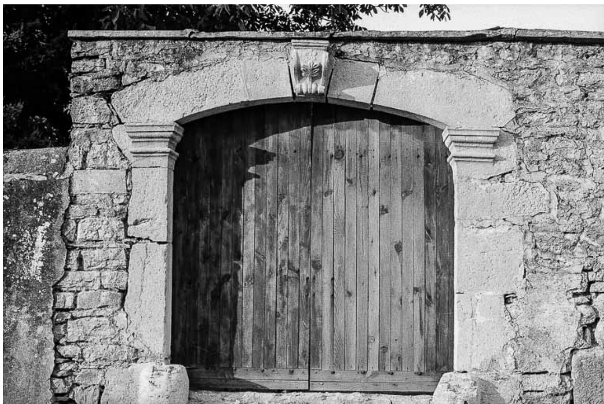
Demeure située 321 rue du Général Lecourbe : portail.
