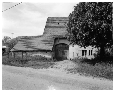
Ferme située rue du Général Gauthier : façade antérieure. Phot. Bernard Lardière IVR43_19793900335X
