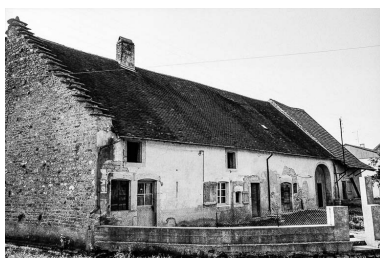
Maison cadastrée 1960 AH 102-104 : façade antérieure. Phot. Bernard Pontefract IVR43_19753900420Z
