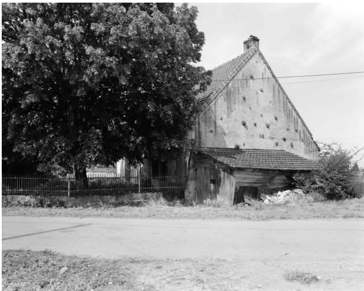
Ferme située rue Saint-Aignan : vue d'ensemble.
