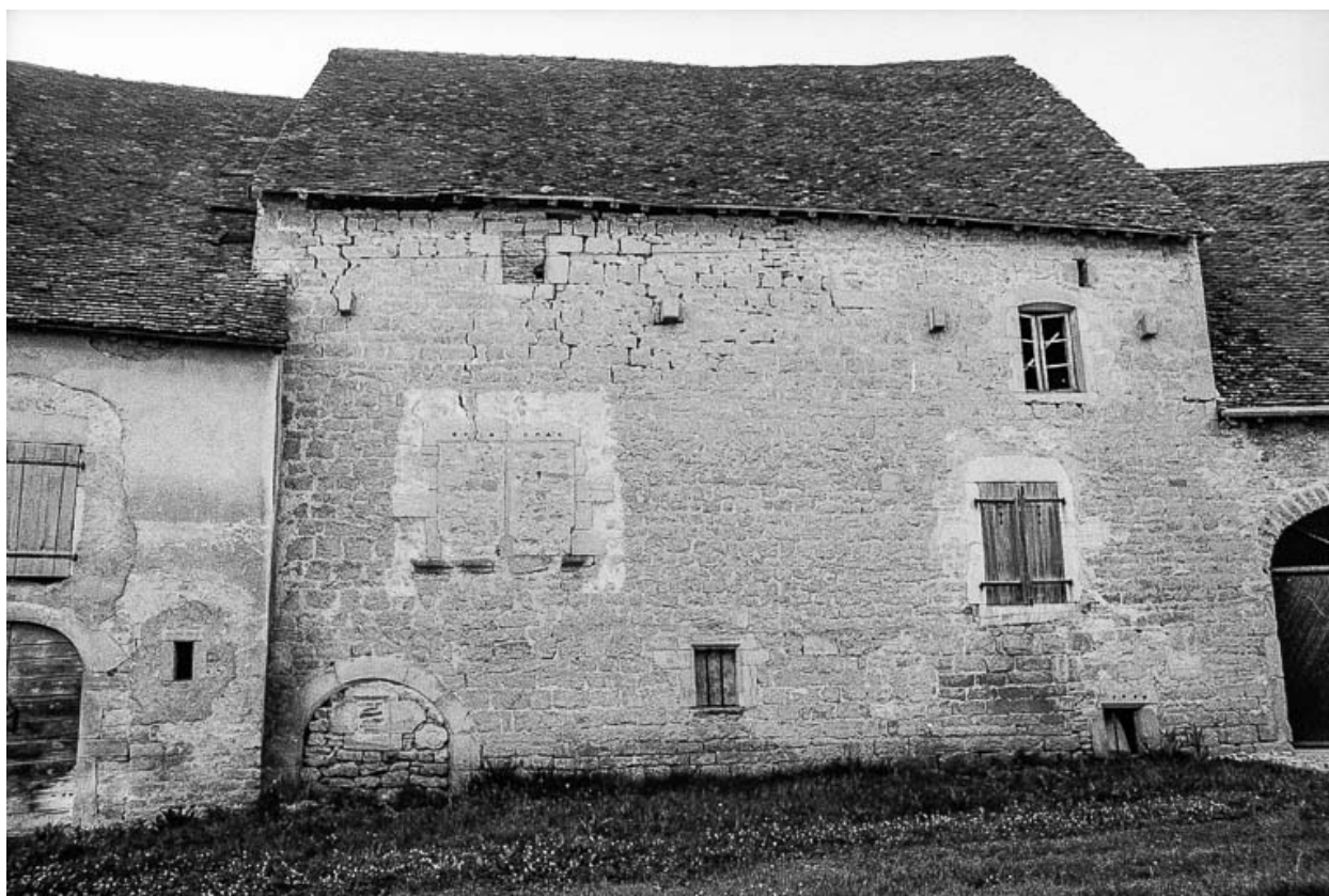
Maison cadastrée 1960 AI 99, située rue du Puits : façade antérieure.
