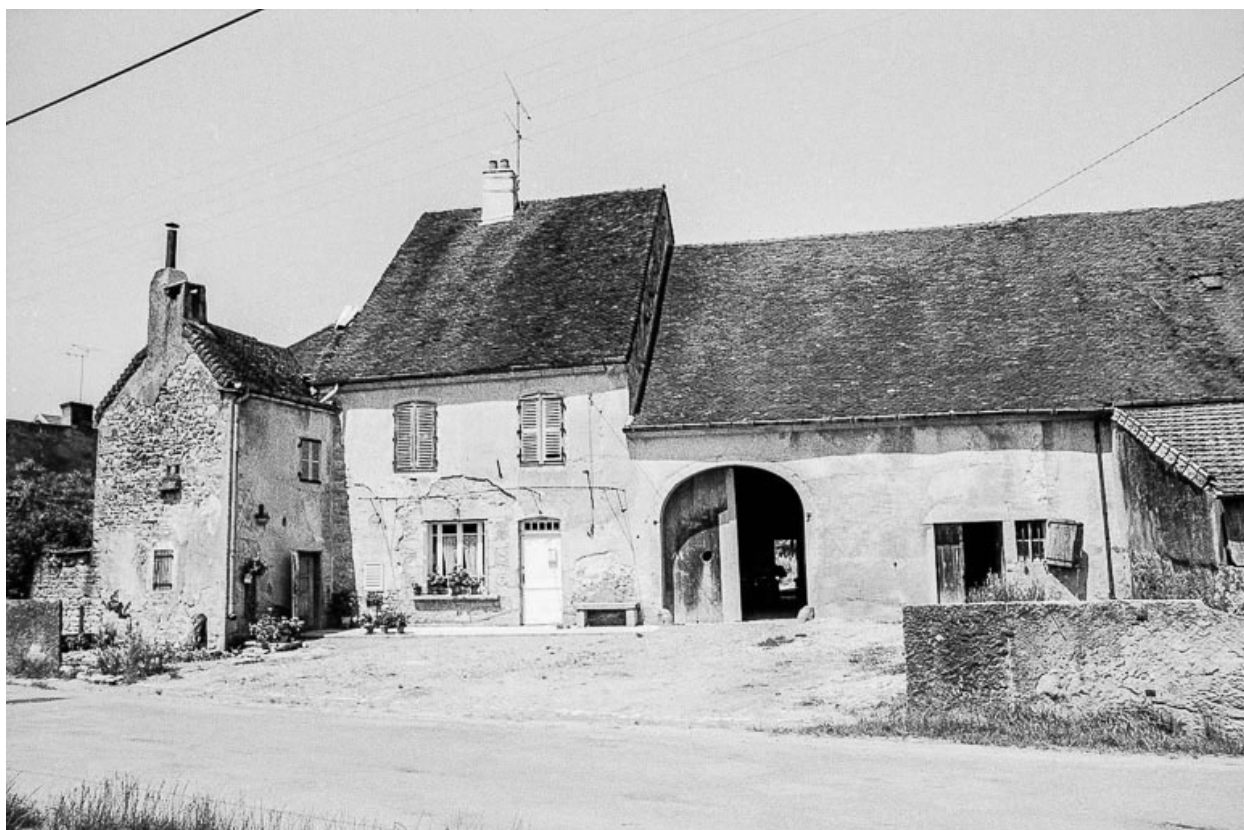
Ferme située rue d'Oisenans : façade antérieure.
