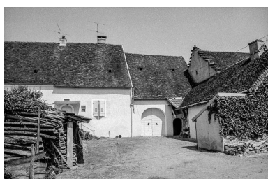
Ferme située rue Saint-Christophe : vue de trois-quarts gauche. Phot. Bernard Pontefract IVR43_19753900407Z
