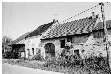
Maison cadastrée 1960 AI 8 : façade antérieure. Phot. Bernard Pontefract IVR43_19753900415Z
