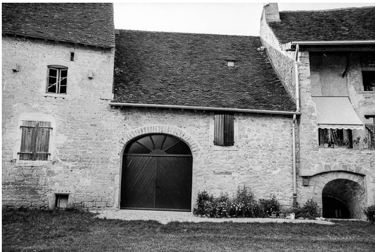
Maison cadastrée 1960 AI 98 (gauche), située rue du Puits : façade antérieure.
