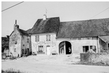
Ferme située rue d'Oisenans : façade antérieure. Phot. Bernard Pontefract IVR43_19753900446Z
