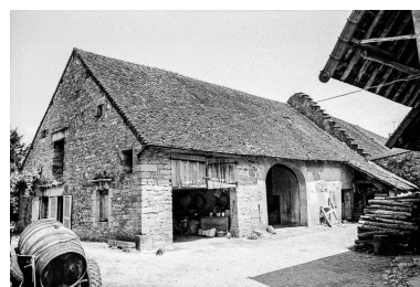
Fermes situées 324-326 rue d'Oisenans : bâtiments d'exploitation. Phot. Bernard Pontefract IVR43_19753900445Z
