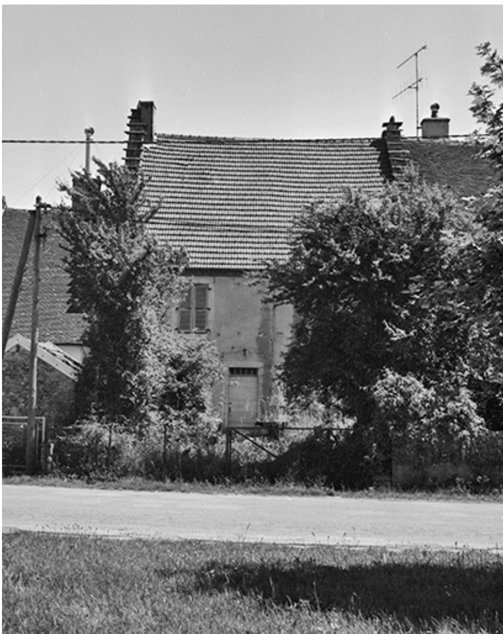
Ferme cadastrée 1960 AI 25 : vue d'ensemble.
