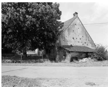
Ferme située rue Saint- Aignan : vue d'ensemble. Phot. Bernard Lardière IVR43_19793900337X
