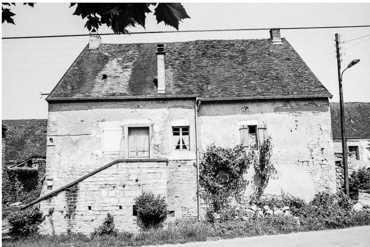
Fermes situées 322 rue d'Oisenans : façades antérieures.
