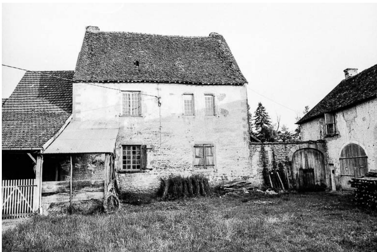
Ferme cadastrée 1960 AI 76 : façade postérieure.
