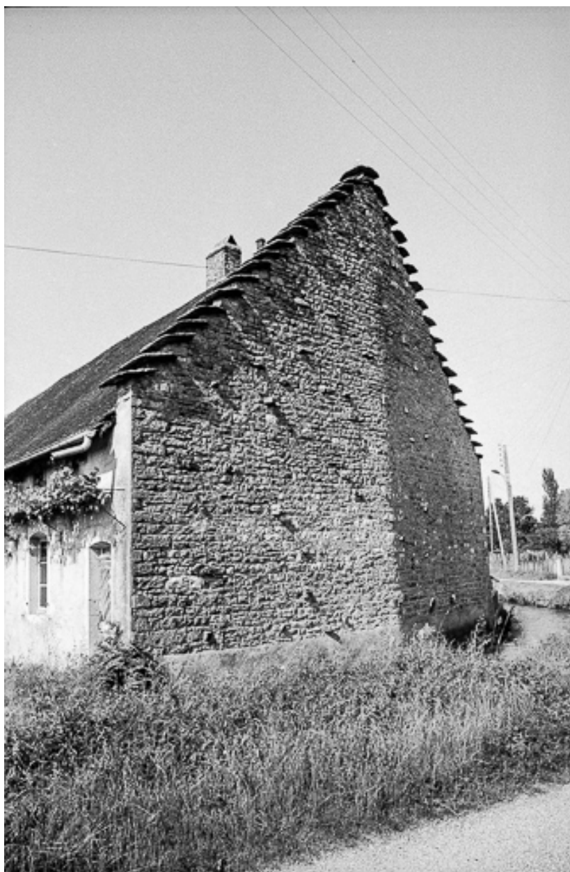
Maison cadastrée 1960 AH 102-104 : façade latérale.
