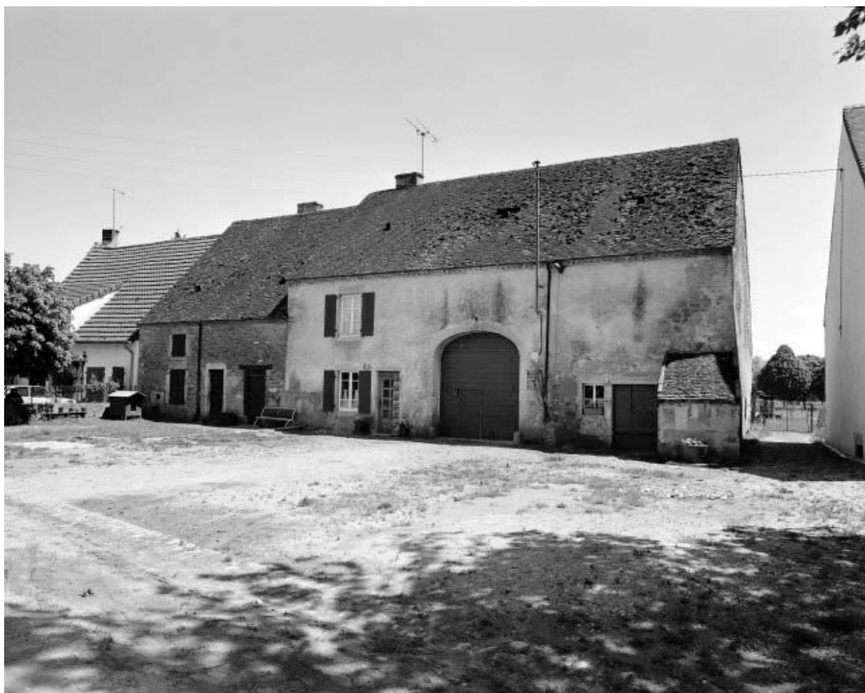
Ferme située rue Neuve : façade antérieure.
