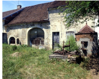
Ferme située rue Saint- Aignan : façade antérieure. Phot. Yves Sancey IVR43_19903901205XA
