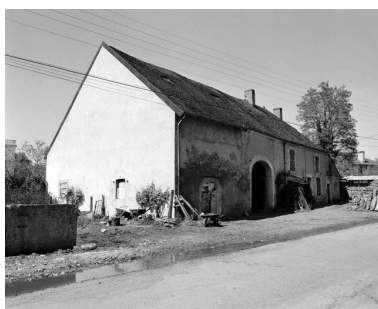
Ferme située rue Neuve : façade antérieure. Phot. Bernard Lardière IVR43_19793900341X
