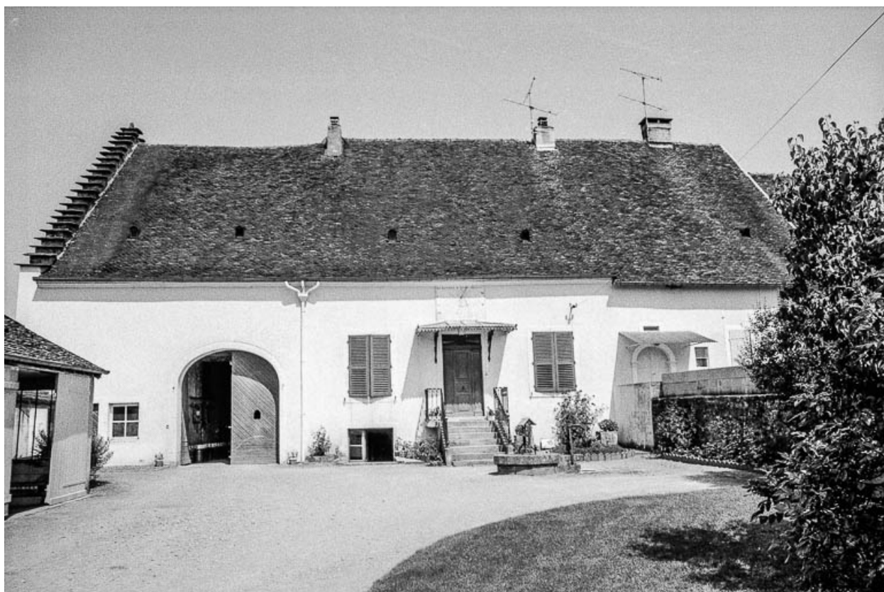
Ferme cadastrée 1960 AE 164, située rue Saint-Christophe : façade antérieure
