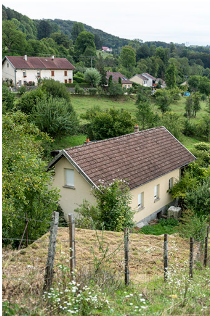
Atelier de polissage, depuis le nord-ouest.
