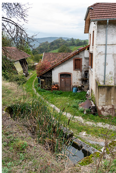
Bâtiment d'eau, vu de l'est. Phot. Sonia Dourlot IVR43_20192501172NUC4A
