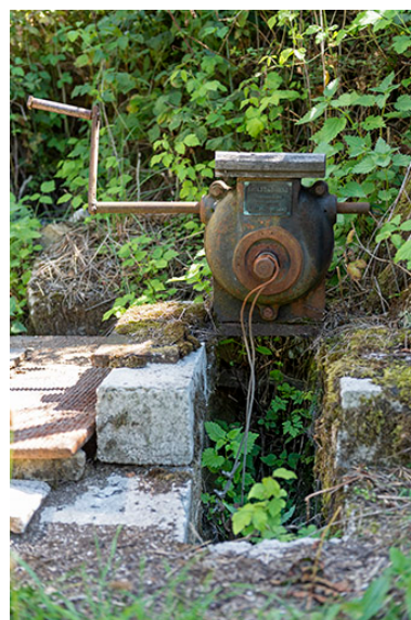
Commande de vanne près du hangar oriental. Phot. Sonia Dourlot IVR43_20192501181NUC4A
