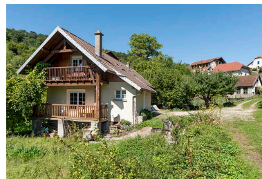
Atelier de polissage, depuis le sud. Phot. Sonia Dourlot IVR43_20192501182NUC4A
