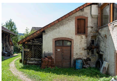
Bâtiment d'eau : façade antérieure. Phot. Sonia Dourlot IVR43_20192501171NUC4A
