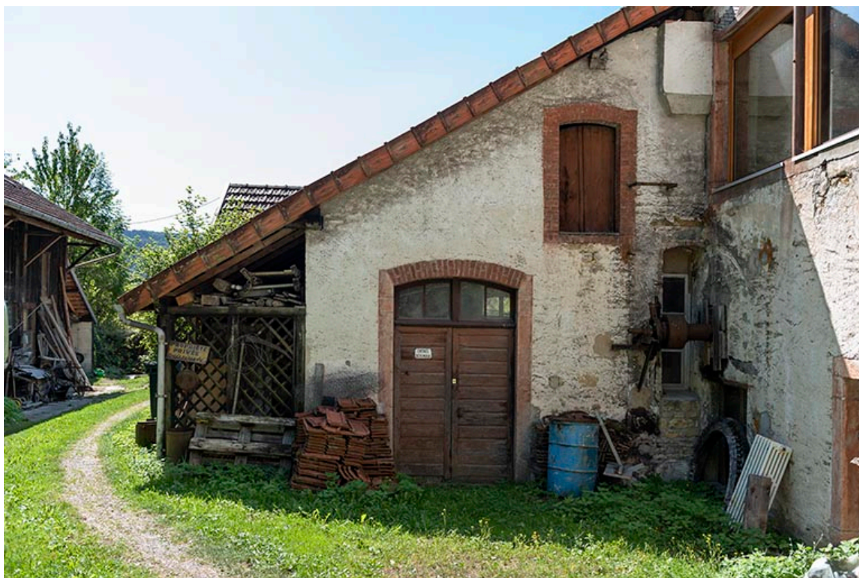
Bâtiment d'eau : façade antérieure.
