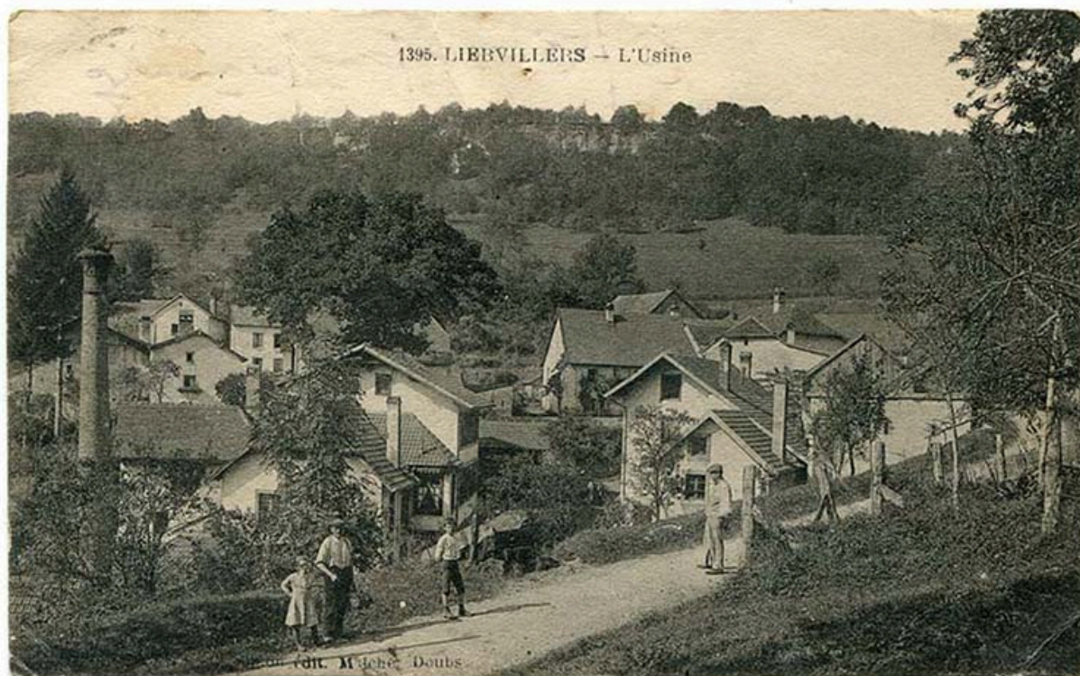
1395. Liebvillers - L'usine, 1ère moitié 20e siècle [avant 1932].
