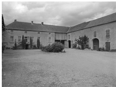
Logis et hangar. Façades sur cour. Phot. Michel Thierry IVR26_19748901171V
