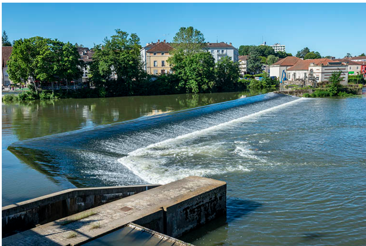
Vue générale depuis la rive droite.
