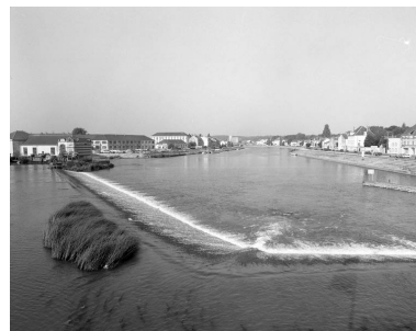
Vue générale du barrage depuis le pont. Phot. Yves Sancey IVR43_19887000050X
