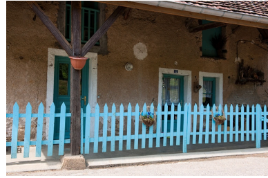
Façade antérieure, vue rapprochée. Phot. Jérôme Mongreville IVR43_20102500395NUC4A
