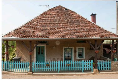
Façade antérieure. Phot. Jérôme Mongreville IVR43_20102500394NUC4A
