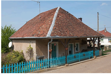
Vue générale. Phot. Jérôme Mongreville IVR43_20102500393NUC4A
