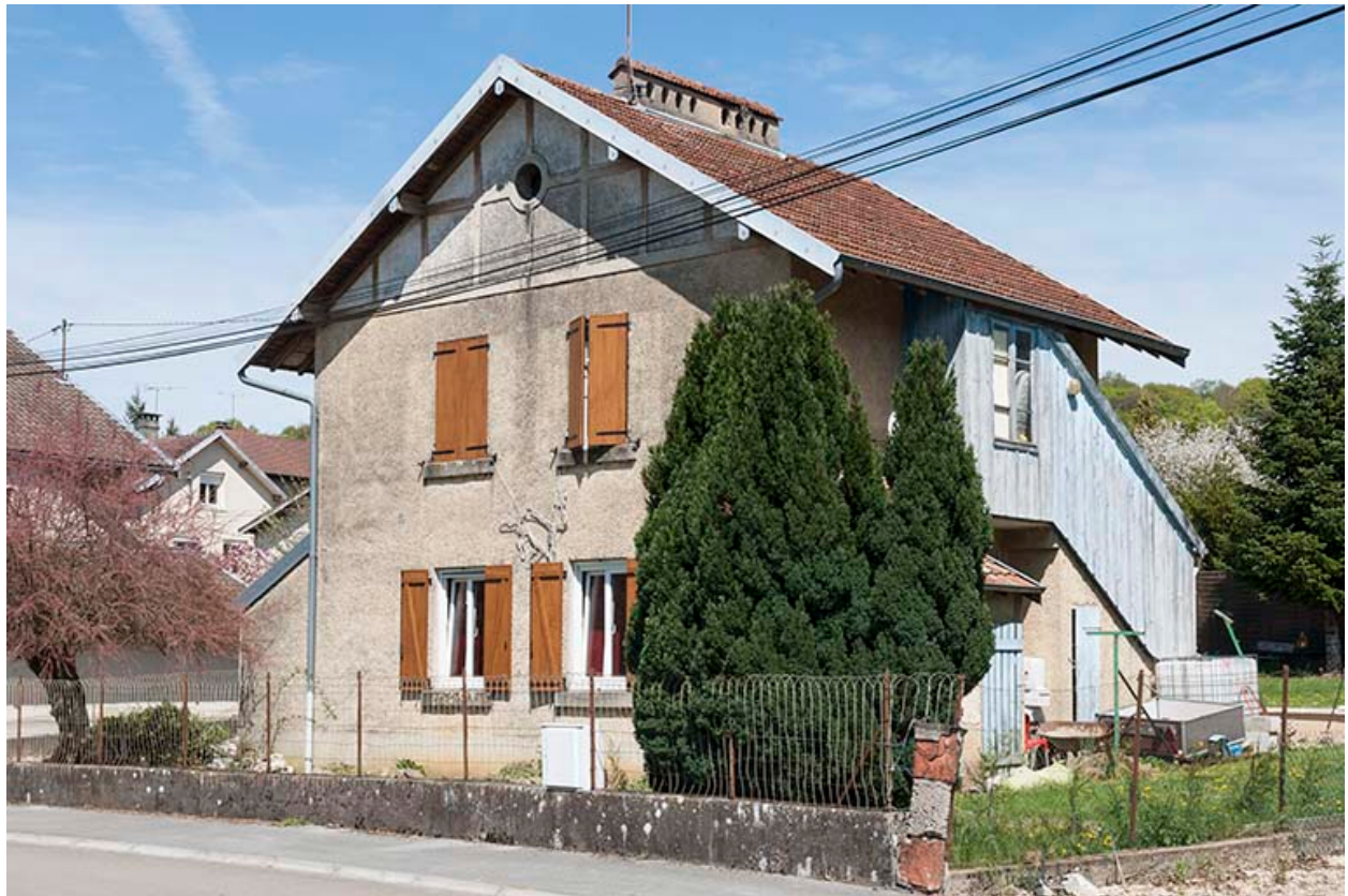
Maison jumelée (21 rue des Salines).
