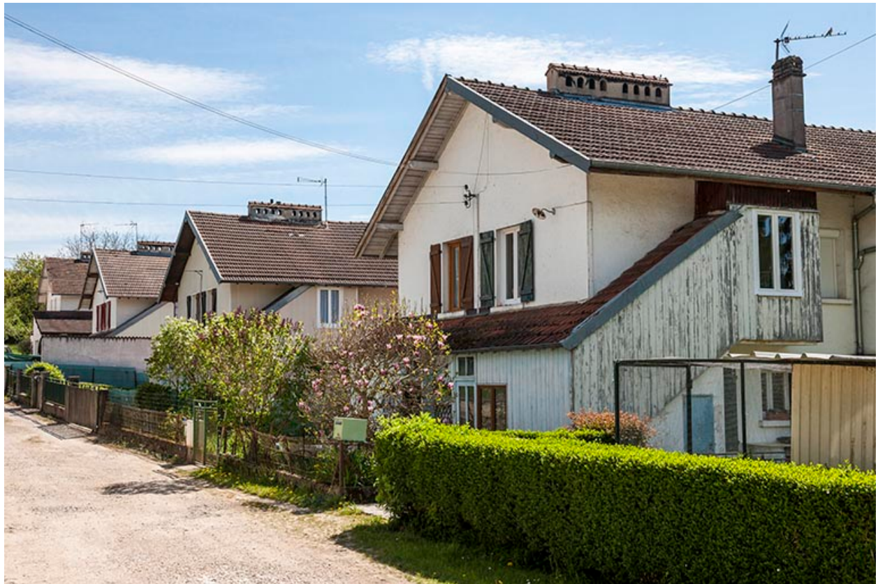
Maisons jumelées (rue des Cités).
