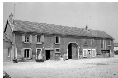
Logement d'ouvriers, écuries et fenil (C). Phot. Laurent Poupard IVR43_19893900238Z
