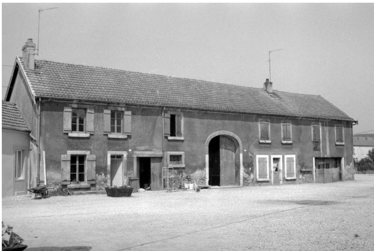
Logement d'ouvriers, écuries et fenil (C).
