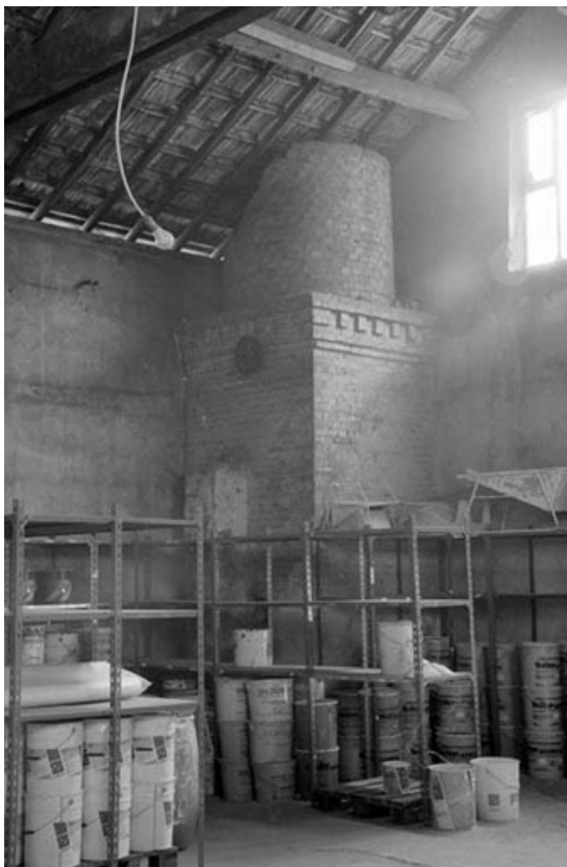
Vestige de la cheminée d'usine.
