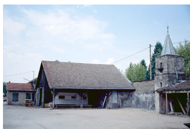
Pigeonnier et hangar. Phot. Laurent Poupard IVR43_19893900239ZA
