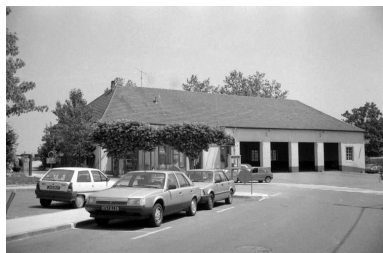
Vue d'ensemble depuis le jardin, au nord. Phot. Laurent Poupard IVR43_19893900236Z
