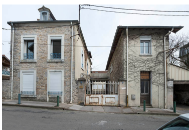
Façade antérieure. Phot. Jérôme Mongreville IVR43_20182500606NUC4A
