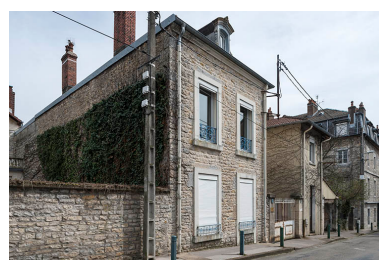
Entrée rue du Château-Rose. Phot. Jérôme Mongreville IVR43_20182500604NUC4A
