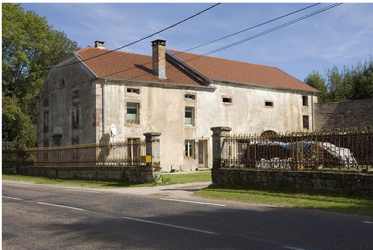
Logement patronal et parties agricoles.
