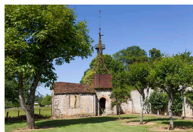
Bâtiment avec éolienne en fond de parcelle. Phot. Sonia Dourlot IVR43_20157000362NUC2A
