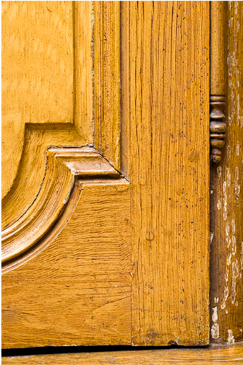
Intérieur : détail des lambris de revêtement du salon, toile peinte à l'imitation du bois.
