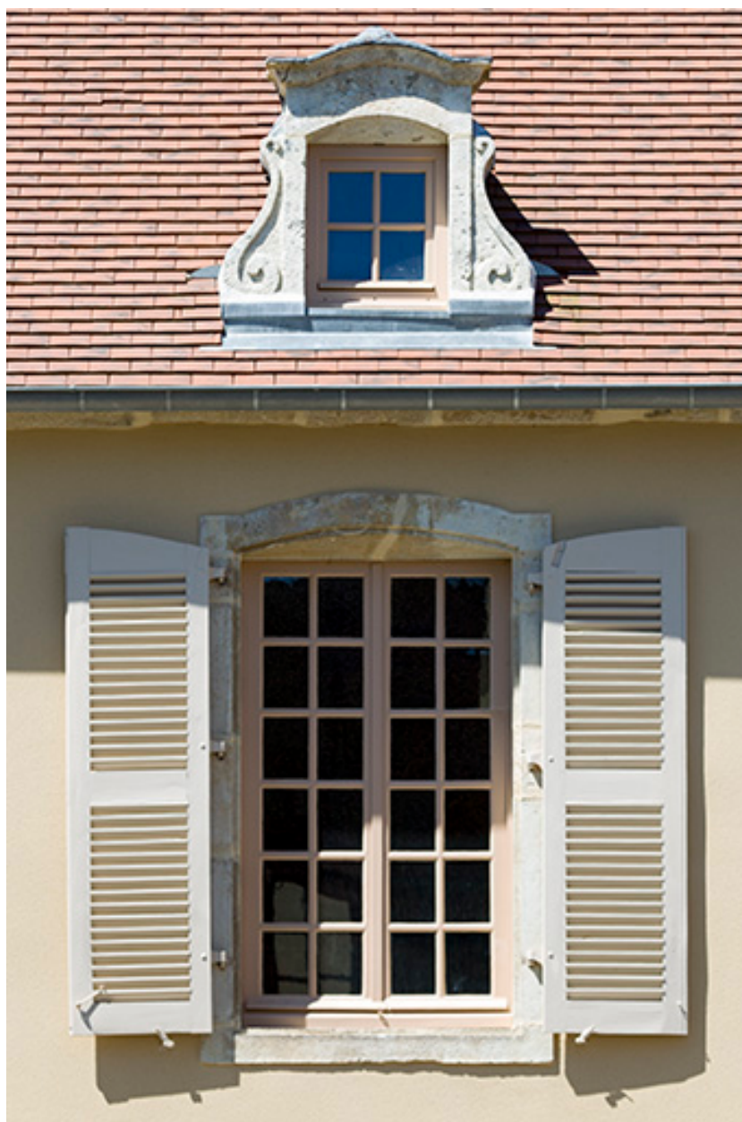
Façade antérieure : une fenêtre du premier étage et une lucarne de l'étage de comble.
