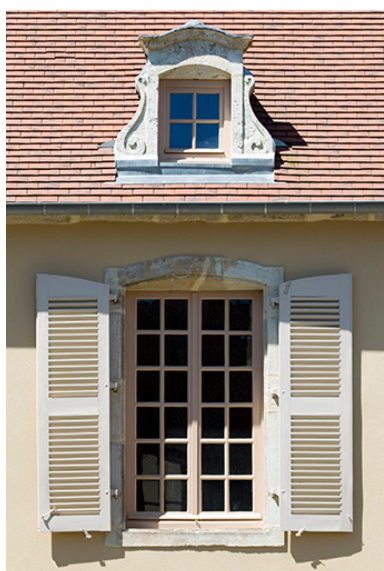
Façade antérieure : une fenêtre du premier étage et une lucarne de l'étage de comble. Phot. Sonia Dourlot IVR43_20157000358NUC2A
