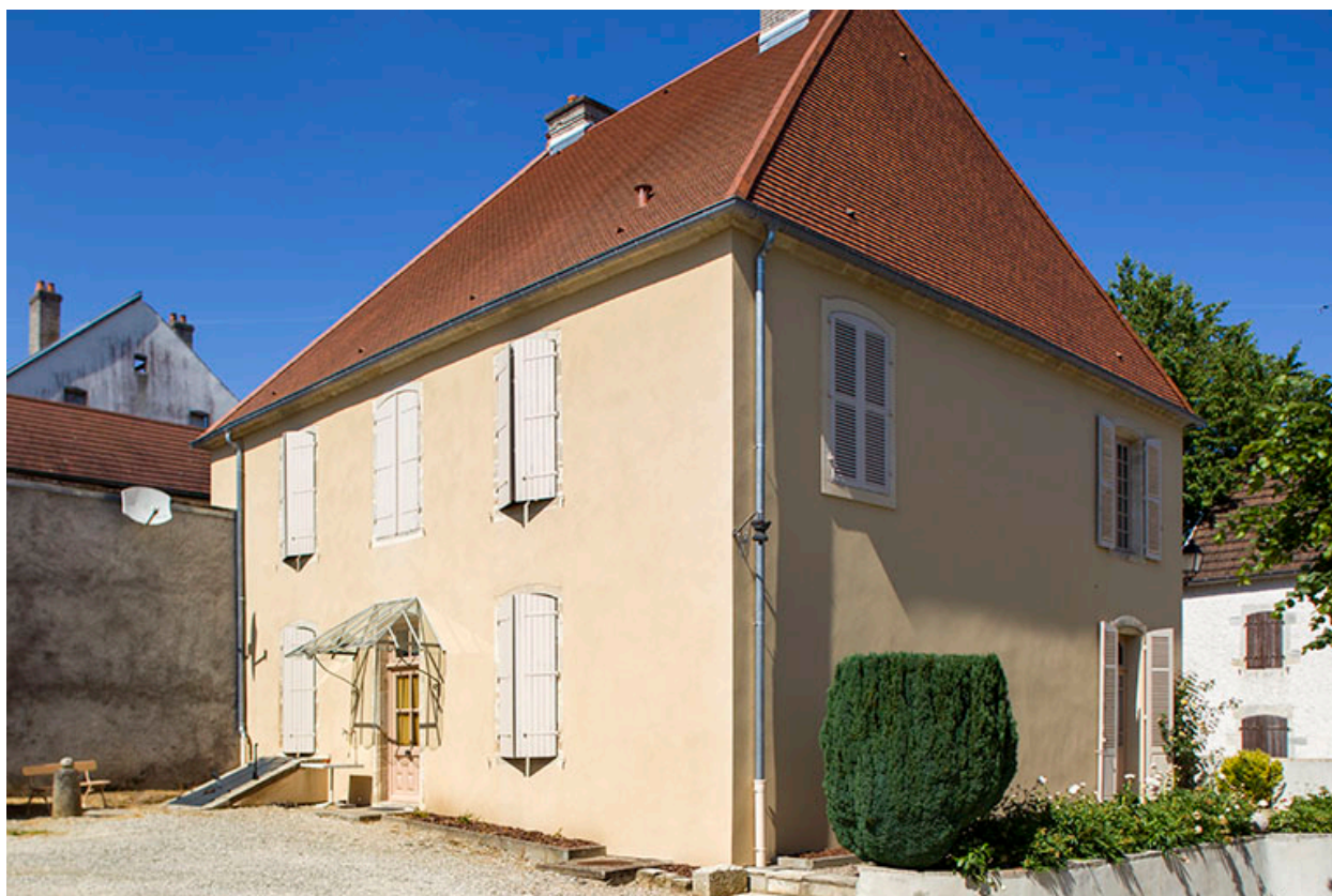
Façade postérieure de trois quart gauche.
