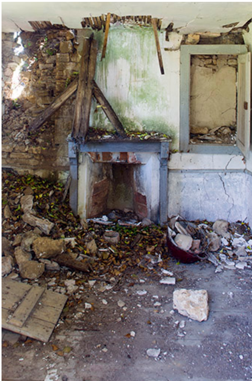
Intérieur du bâtiment : une pièce avec cheminée.
