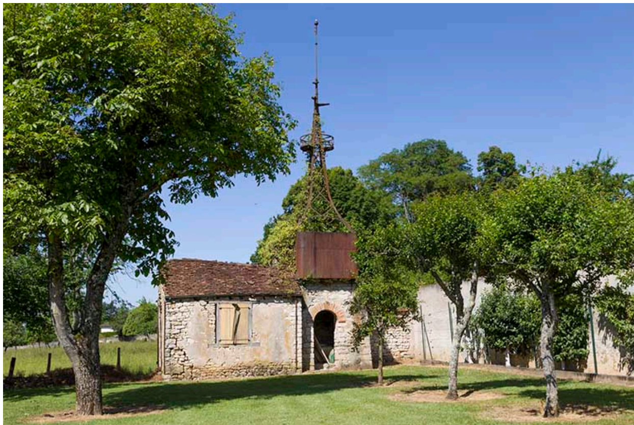
Bâtiment avec éolienne en fond de parcelle.
