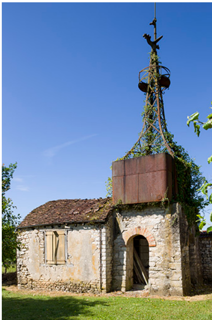
Vue rapprochée du bâtiment et de l'éolienne.
