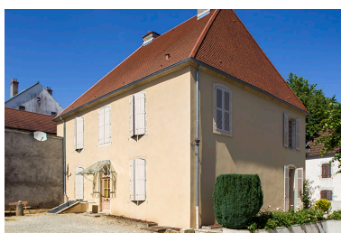
Façade postérieure de trois quarts gauche. Phot. Sonia Dourlot IVR43_20157000359NUC2A
