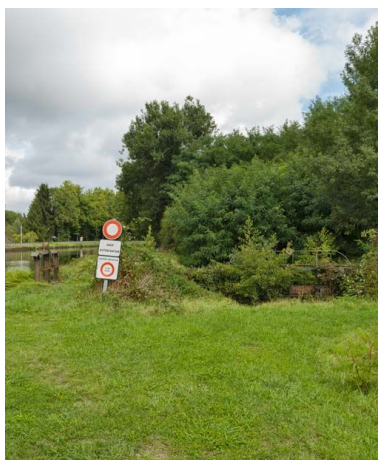
A gauche, le canal avec la prise d'eau. A droite, la passerelle sous laquelle passe le ruisseau du Moulin de Fougère qui part ensuite contourner l'étang du Fourneau. Phot. Pierre-Marie Barbe-Richaud IVR26_20177100288NUC2A
