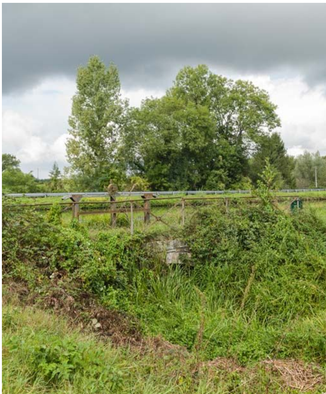
Vue rapprochée de l'ouvrage.
