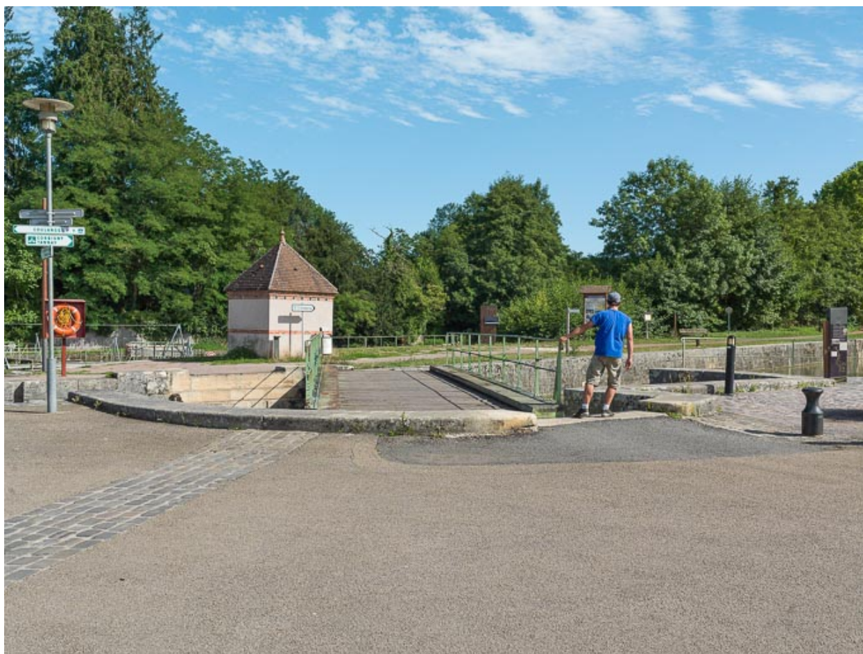
Vue du pont, manoeuvré par l'éclusier.
