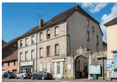
Élévation sur la rue Armand Paulmard, vue de trois-quarts. Phot. Jérôme Mongreville IVR43_20187000402NUC4A
