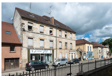
Élévation sur la rue Armand Paulmard, vue de trois-quarts. Phot. Jérôme Mongreville IVR43_20187000403NUC4A
