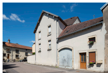
Élévation sur la rue André Bergerot. Phot. Jérôme Mongreville IVR43_20187000404NUC4A
