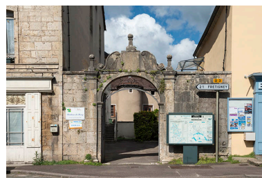
Portail de la cour. Phot. Jérôme Mongreville IVR43_20187000398NUC4A
