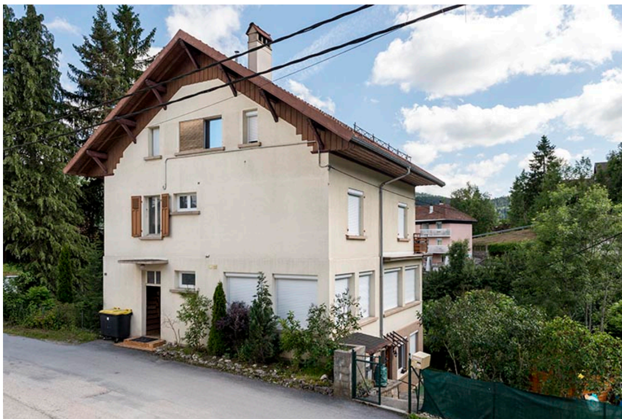
Façades antérieure et latérale droite.
