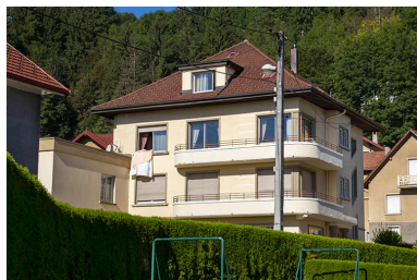
Façades postérieure et latérale gauche.
