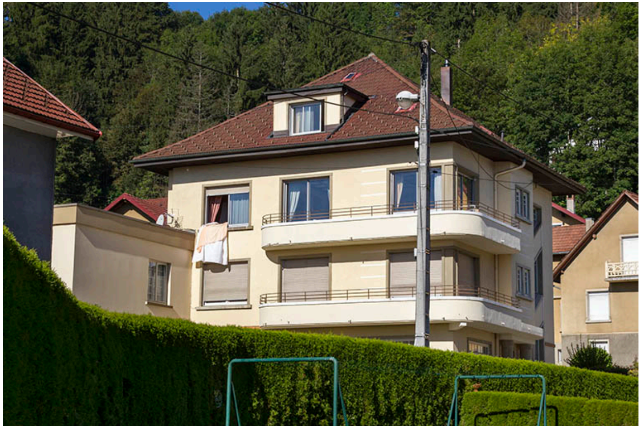
Façades postérieure et latérale gauche.
