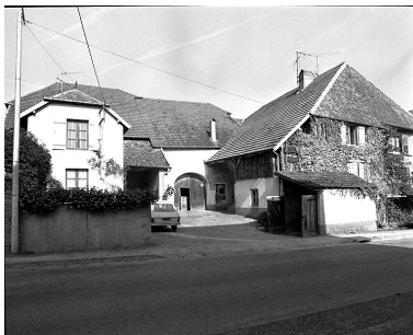
Façade antérieure sur cour ouverte. Phot. Dominique Dominguez IVR43_19807000320X
