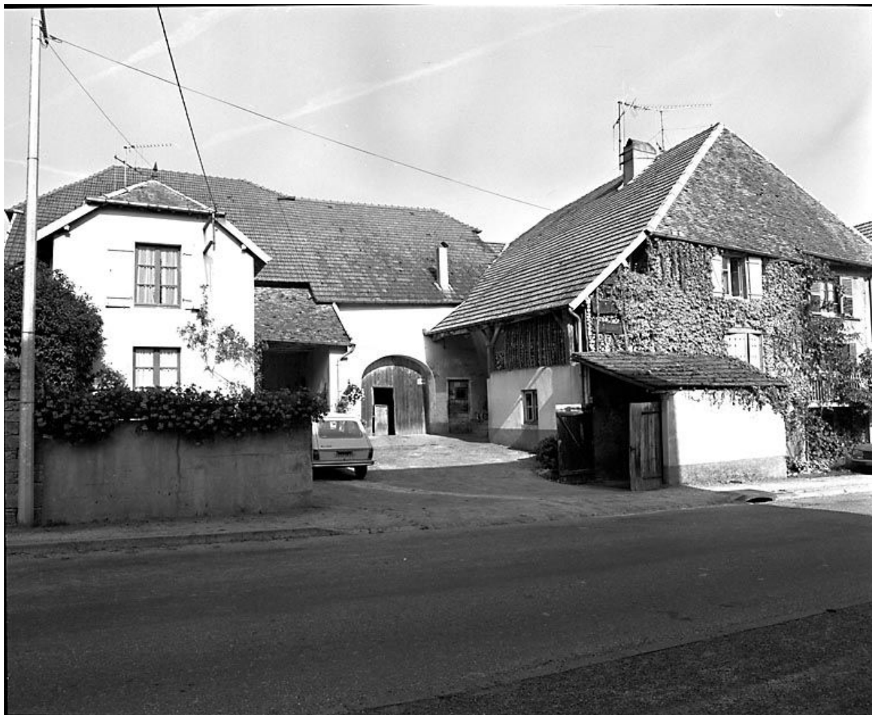
Façade antérieure sur cour ouverte.
