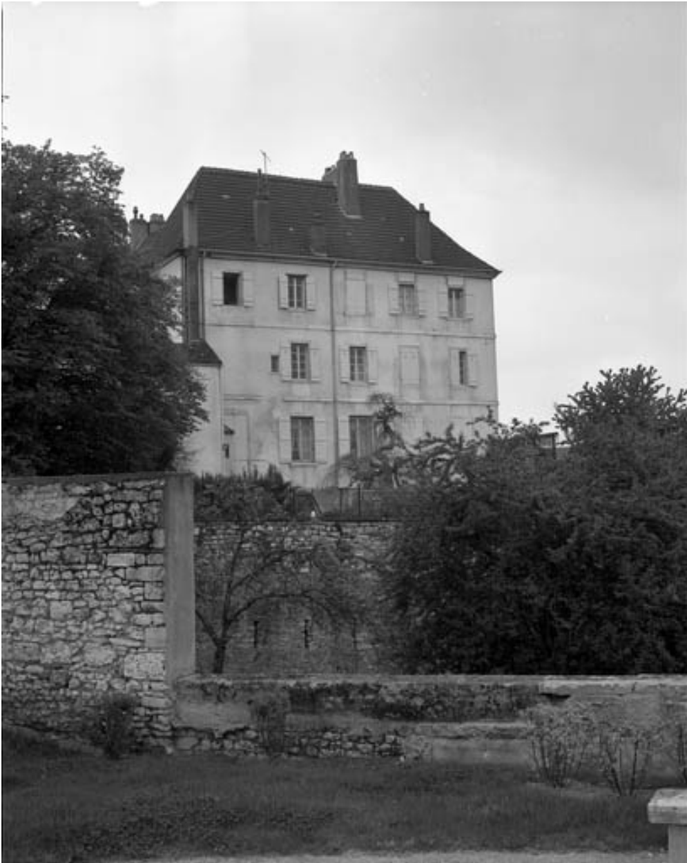
Façade latérale du bâtiment principal.
