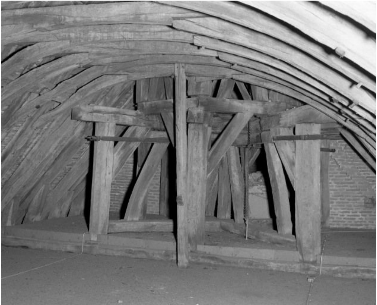
Charpente du comble et beffroi
