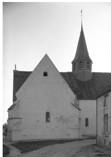
Elévation gauche, chapelle Phot. Jean-Luc Duthu IVR26_19852101129V
