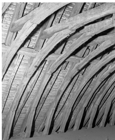
Charpente du comble Phot. Michel Thierry IVR26_19852101219X
