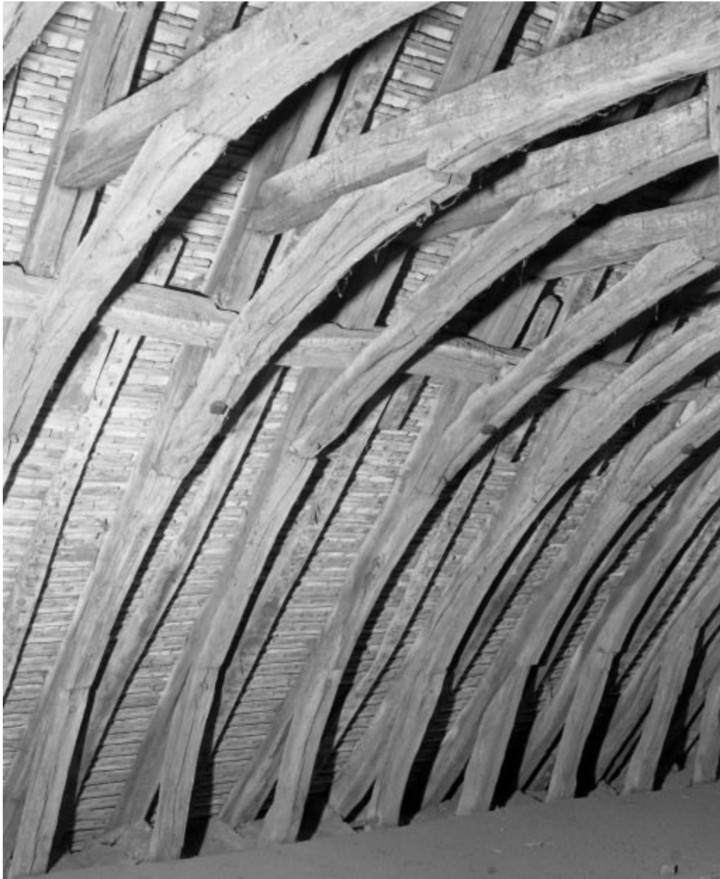
Charpente du comble
