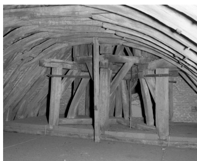
Charpente du comble et beffroi Phot. Michel Thierry IVR26_19852101216X
