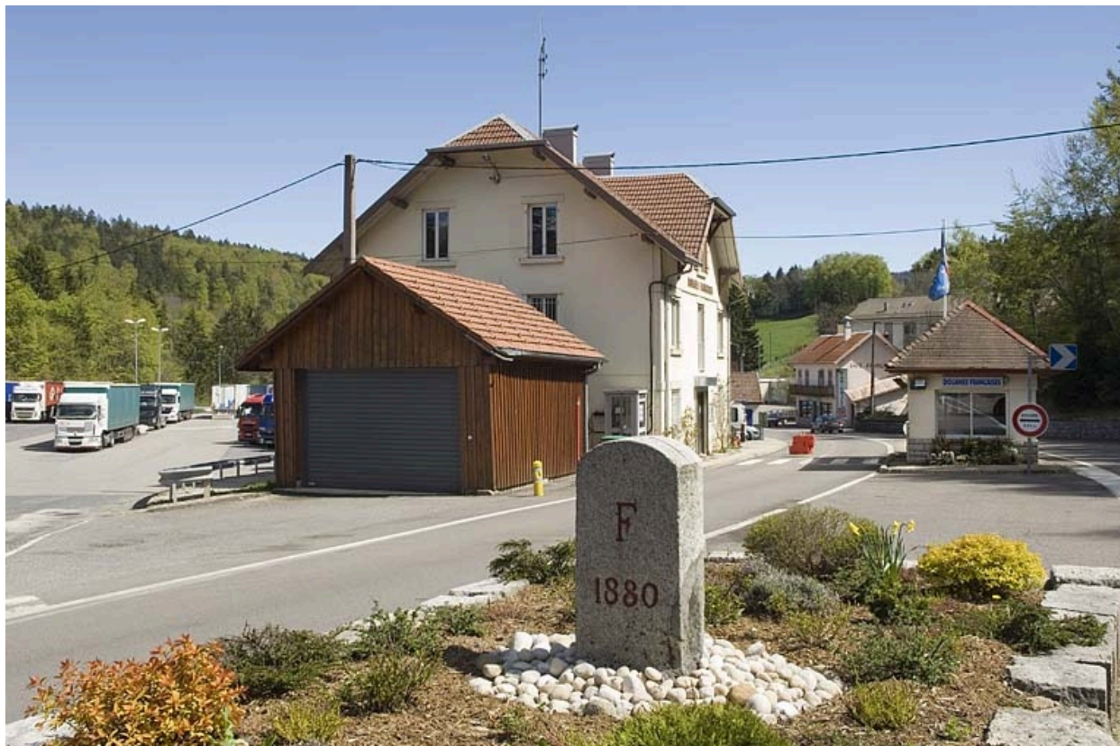
Vue d'ensemble des bâtiments de la douane.
