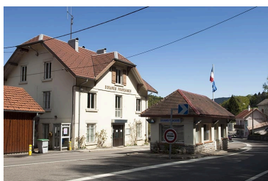
Vue du bureau des douanes et du poste de surveillance. Phot. Jérôme Mongreville IVR43_20092501644NUC2A
