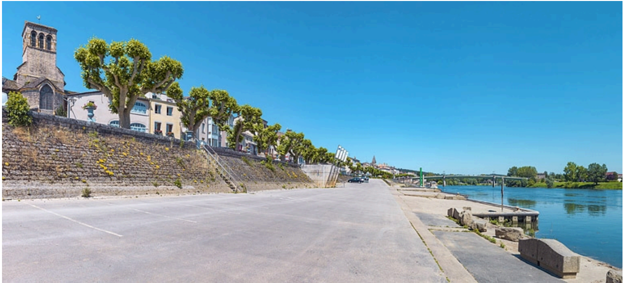
Quai sud, au pied de l'église Sainte-Madeleine.
