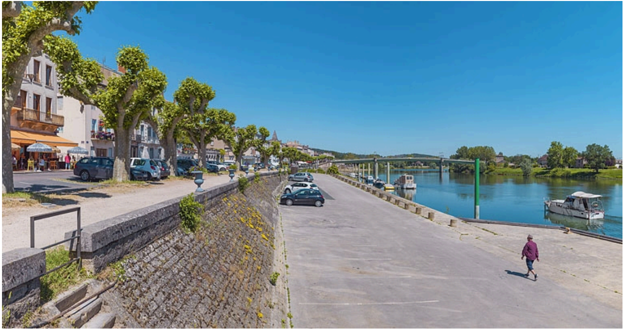
Quai sud, dans le prolongement des quais à gradins.
