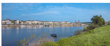
Le quai à gradins et le port sud, vus depuis la rive gauche.
