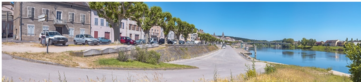
Vue d'ensemble du quai sud.
