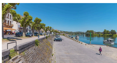
Quai sud, dans le prolongement des quais à gradins.
