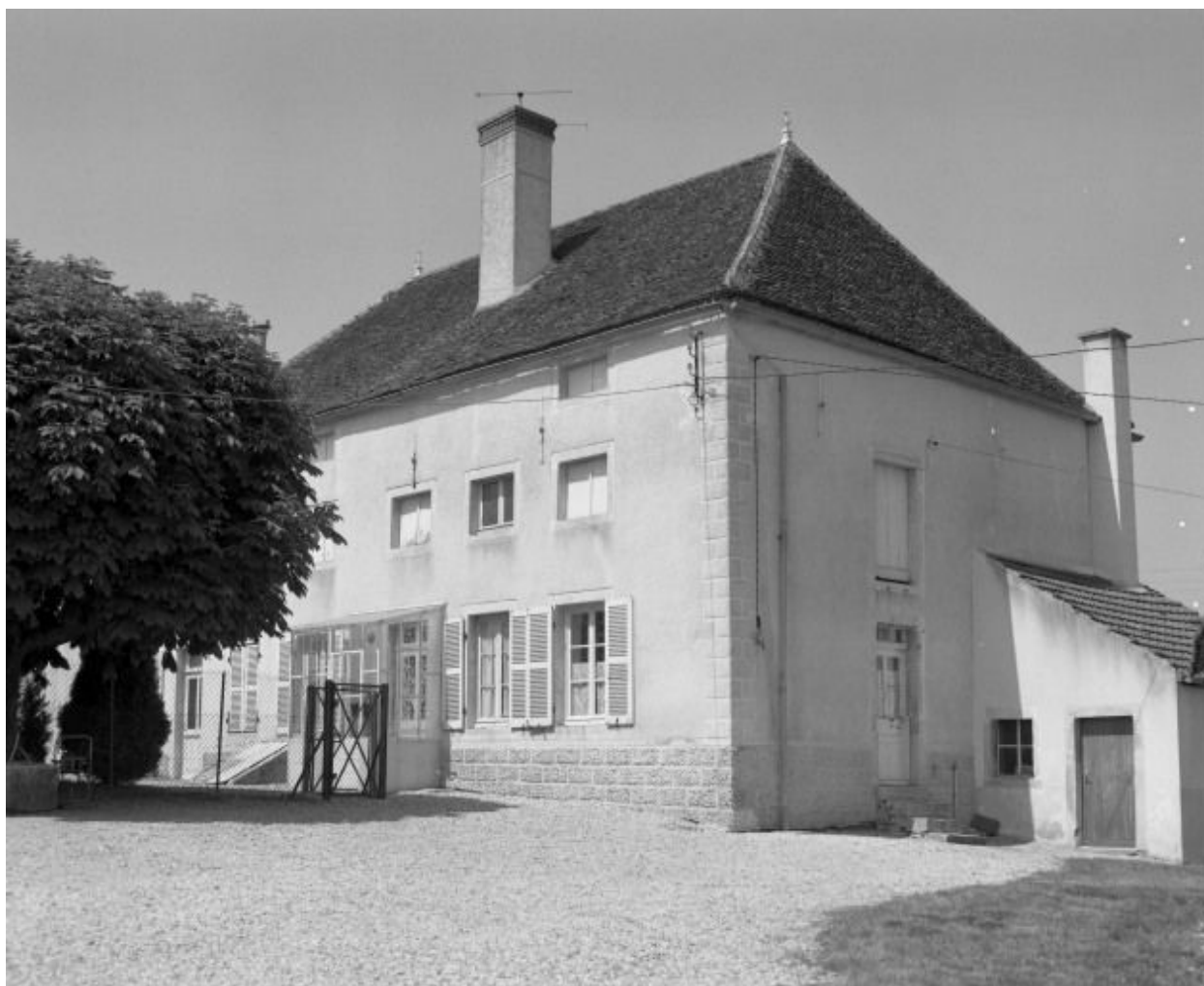
Bâtiment d'habitation d'une ferme (cad. 1935, sect. D1, parc. 146).
