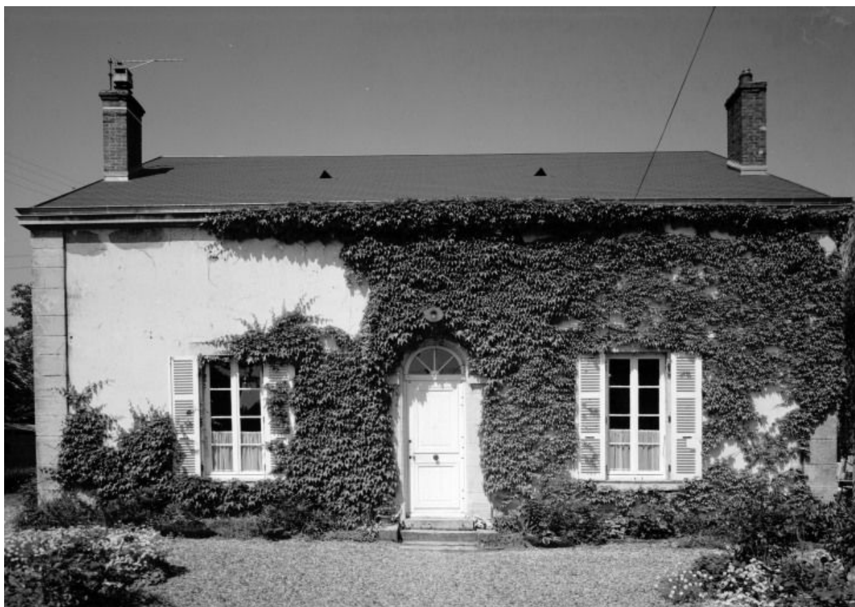
Façade d'une maison (cad. 1935, sect. B1, parc. 199).
