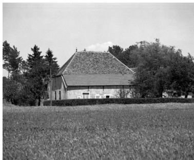
Vue d'ensemble d'une ferme (cad. 1935, sect. A, parc. 227). Phot. Michel Rosso IVR26_19862100630X
