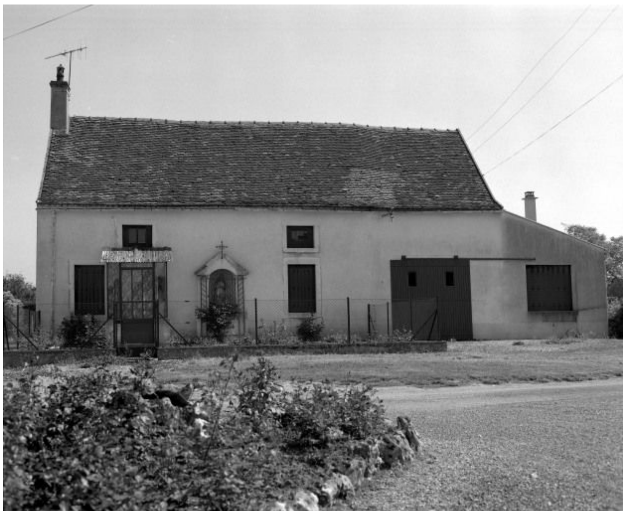
Façade d'une maison (cad. 1935, sect. B1, parc. 270).
