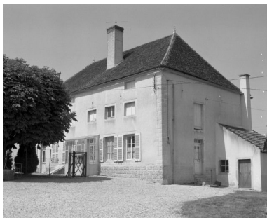
Bâtiment d'habitation d'une ferme (cad. 1935, sect. D1, parc. 146). Phot. Michel Rosso IVR26_19862100649X
